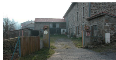
Vue d'ensemble de la cour de la ferme depuis le nord. Phot. Thierry Monnet IVR82_20124200169NUCA
