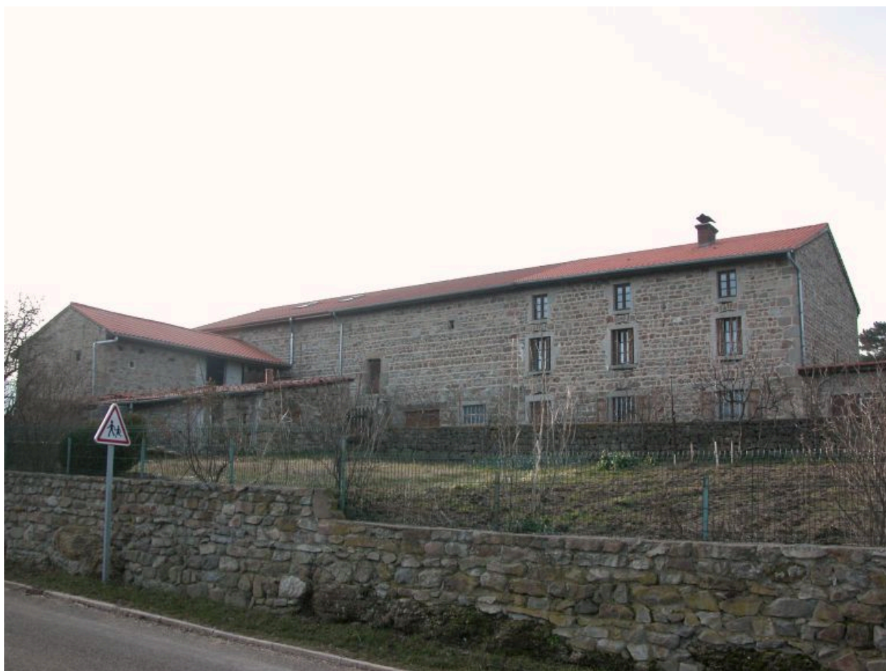
Vue d'ensemble de trois-quarts de la ferme depuis le nord-est.
