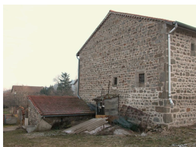
Vue d'ensemble de trois-quarts du mur pignon nord de la ferme. Phot. Thierry Monnet IVR82_20124200172NUCA
