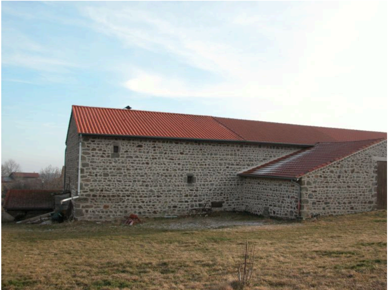
Vue partielle de l'arrière de la ferme, partie de gauche.
