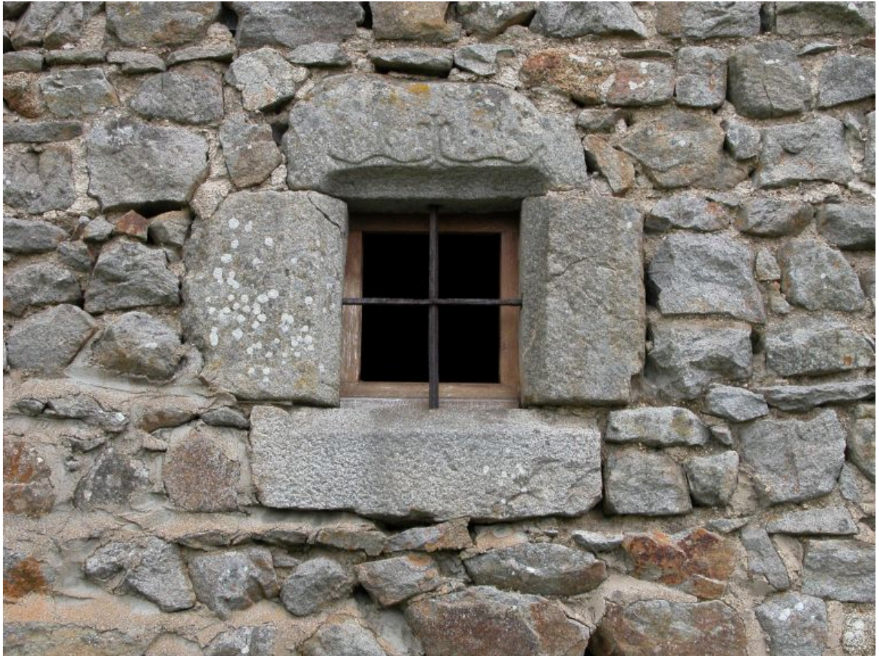
Petite baie en remploi sur l'arrière du logis.
