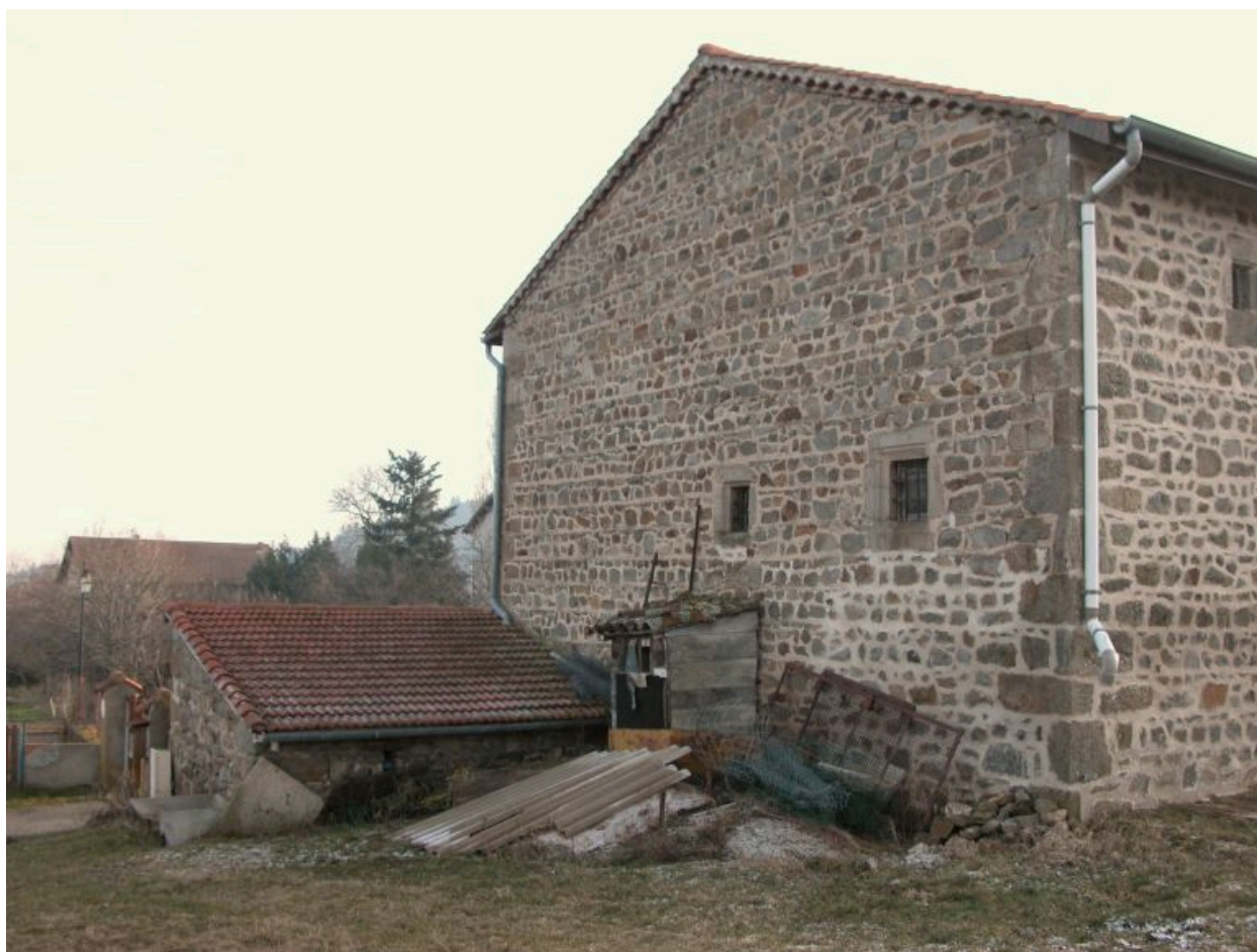
Vue d'ensemble de trois-quarts du mur pignon nord de la ferme.
