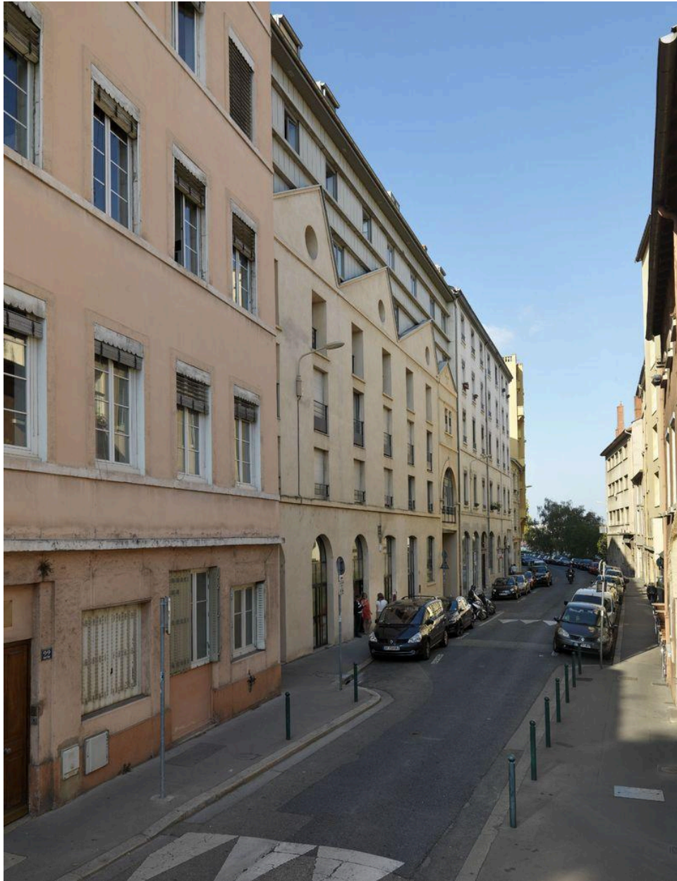
Vue d'ensemble de la façade reconverte en 2001
