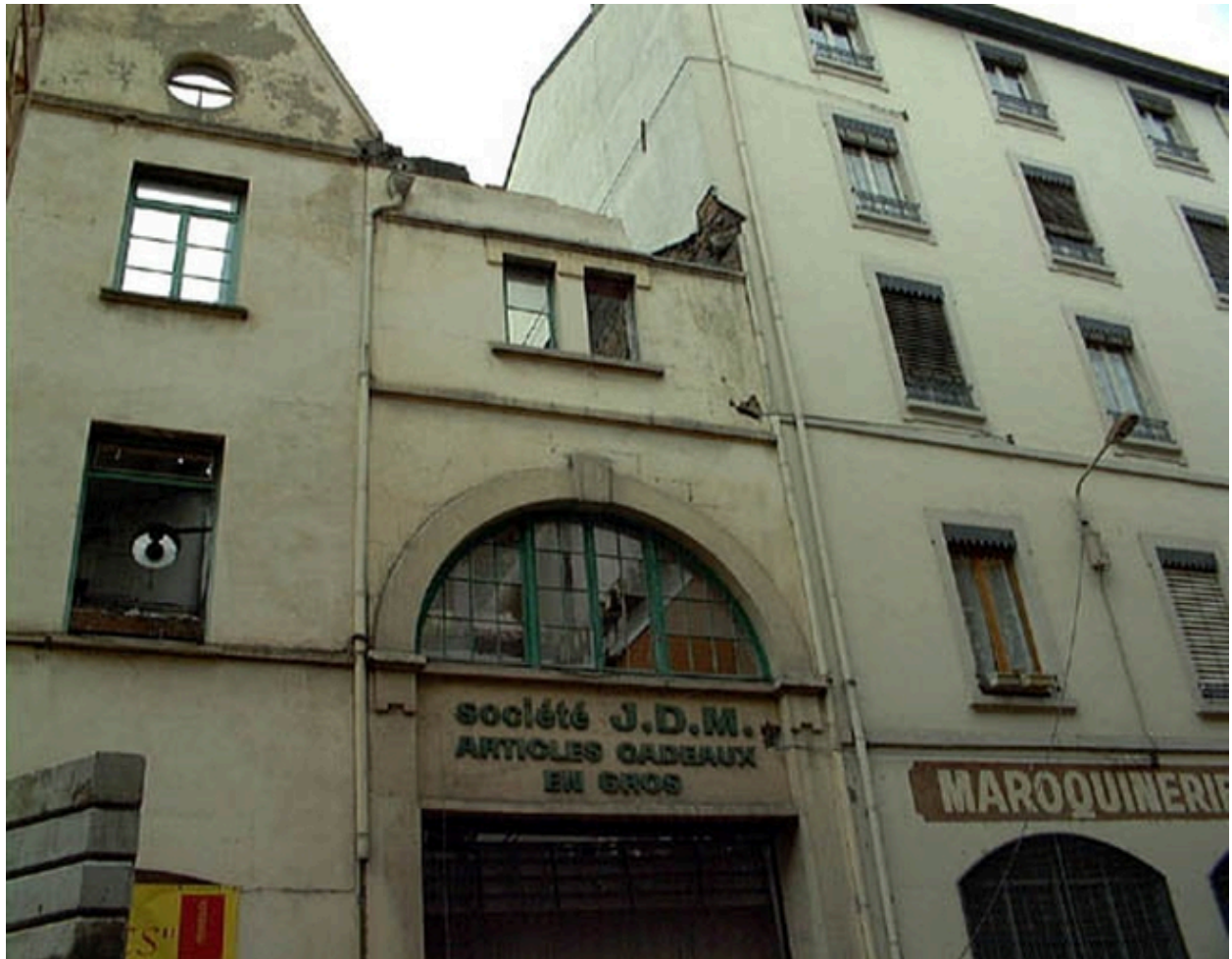
Détail entrée principale : haut de façade
