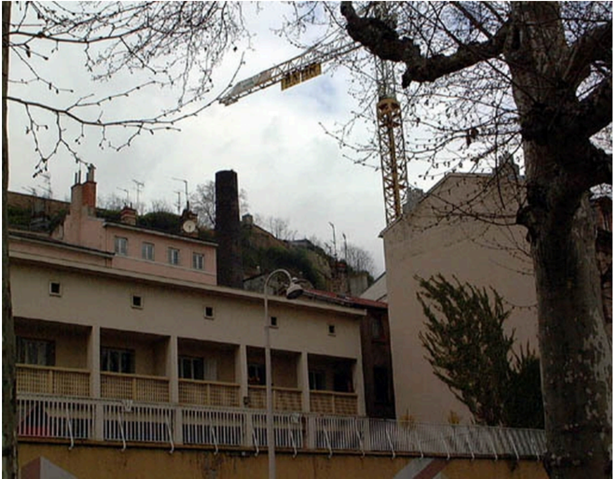
Vue de la cheminée du quai de Saône
