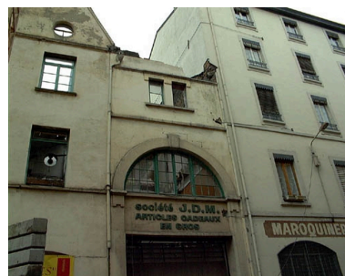
Détail entrée principale : haut de façade Phot. Nadine Halitim-Dubois IVR82_20006900904NUCA
