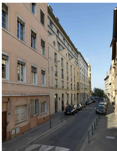
Vue d'ensemble de la façade reconvertie en 2001
