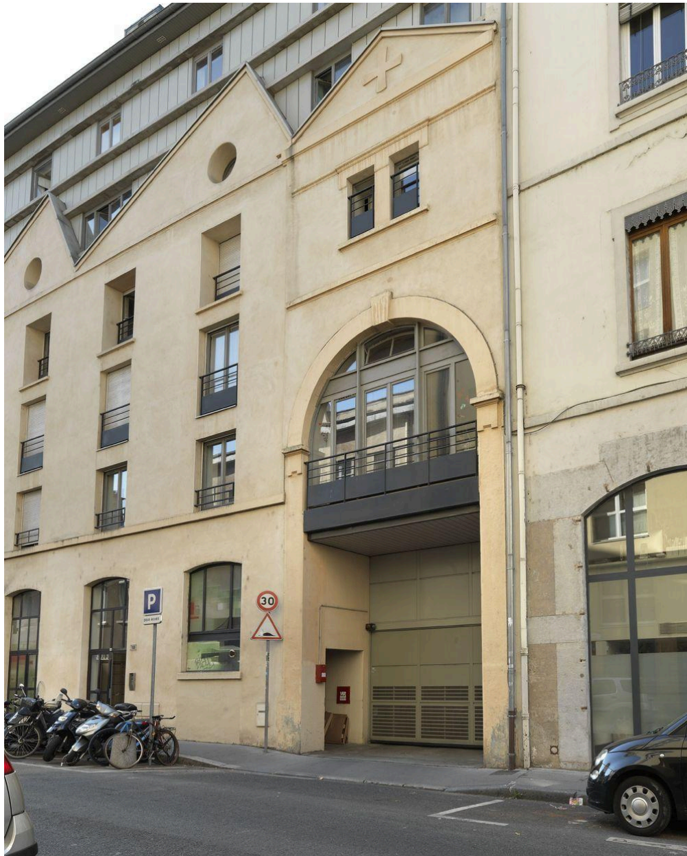
Détail façade reconverte avec croix de Malte en 2001
