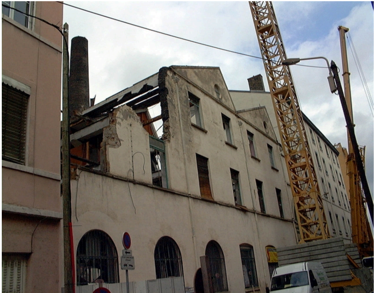
Vue d'ensemble sud-est du site et de la cheminée.
