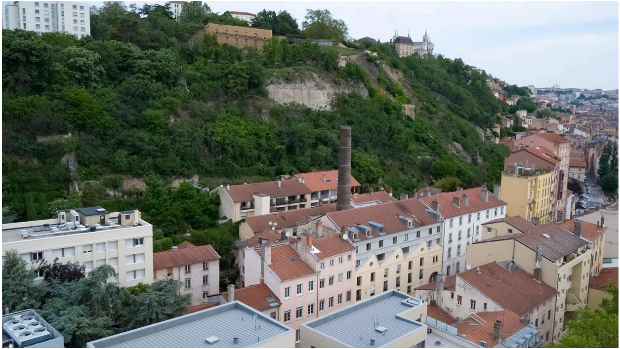
Vue d'ensemble de l'usine et de la cheminée (drone).
