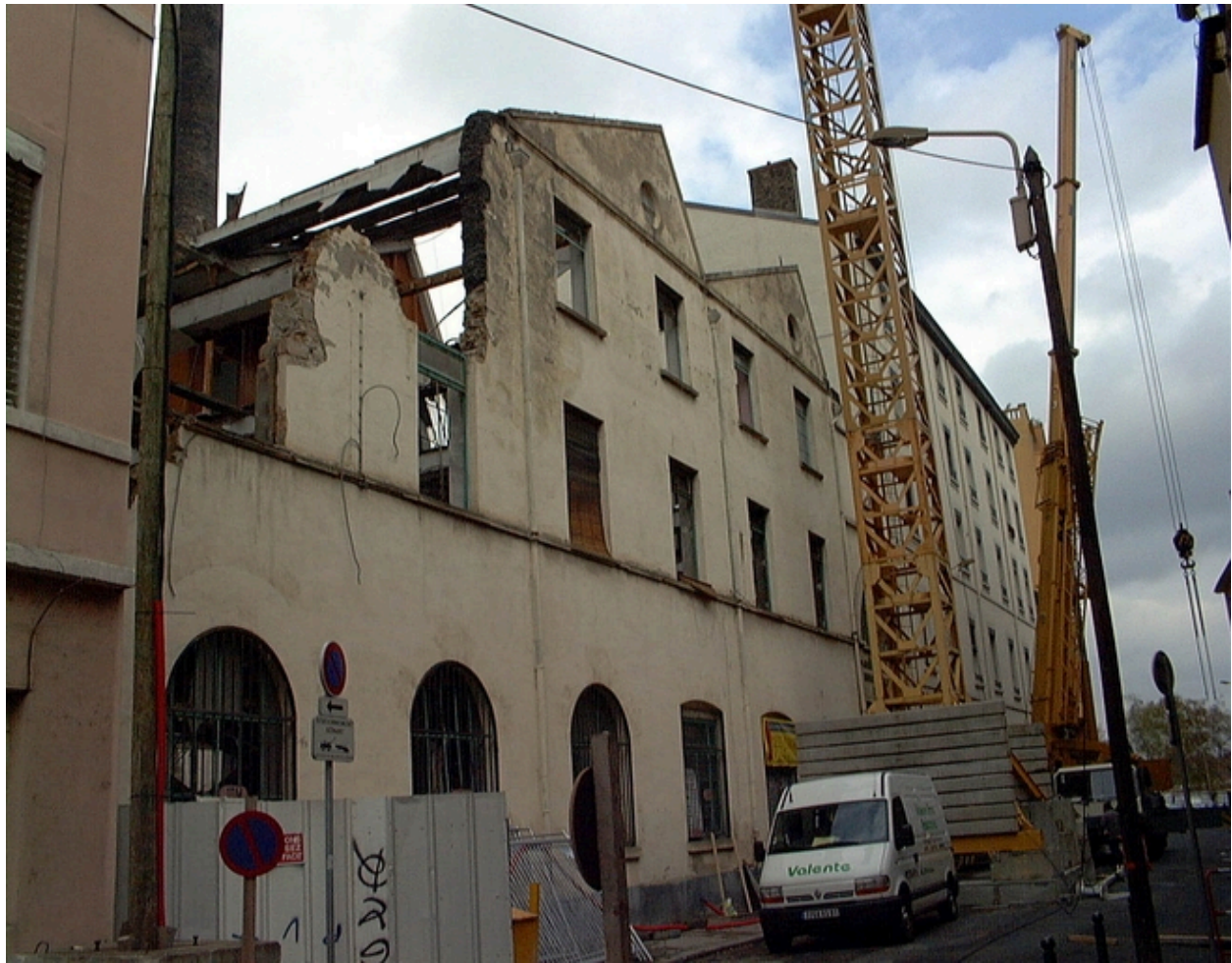
Vue d'ensemble du site de la rue de la Quarantaine
