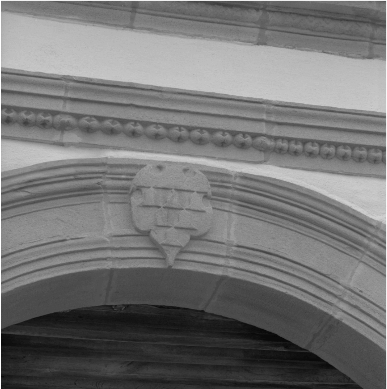
Façades sur la cour d'honneur, détail d'une clef d'arc.
