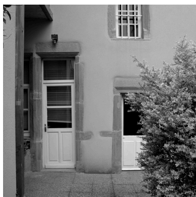
Porte piétonne du vestibule débouchant sur la cour. Phot. Eric Dessert IVR82_20064200585NUCA
