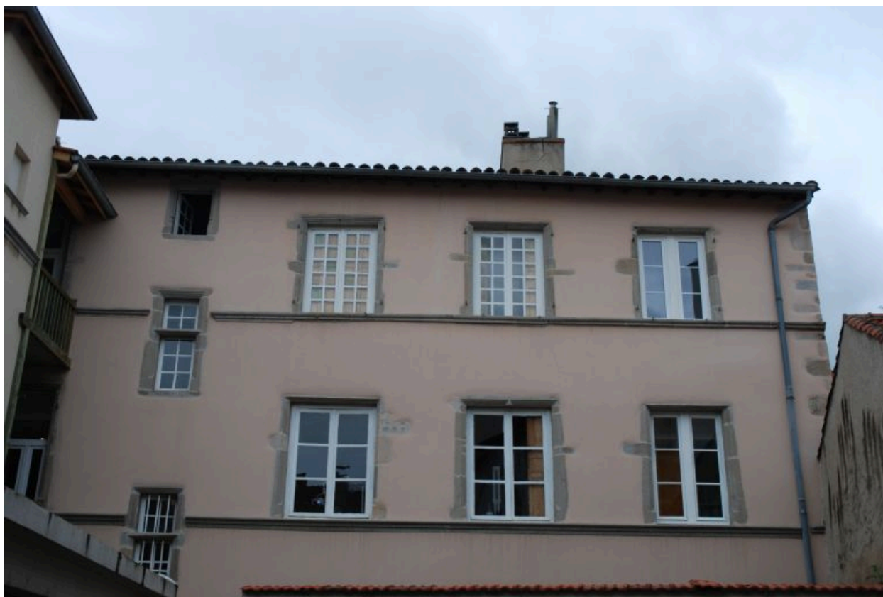
Vue partielle de l'élévation postérieure sur cour.
