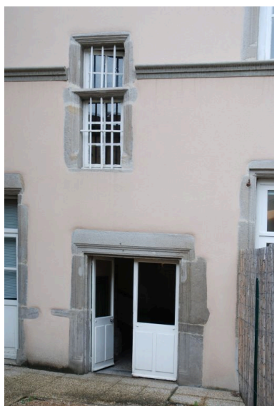
Porte bâtarde sur cour. Phot. Simone Hartmann-Nussbaum IVR82_20124202587NUCA
