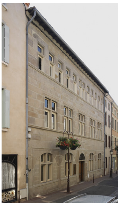
Vue générale. Phot. Eric Dessert IVR82_20064200670NUCA
