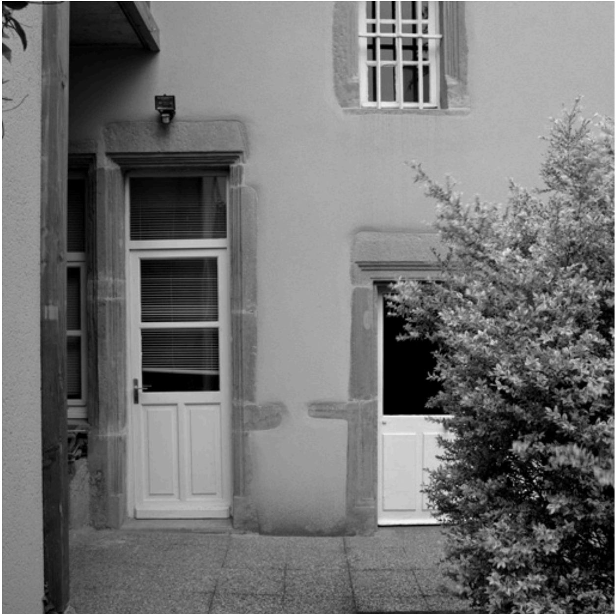
Porte piétonne du vestibule débouchant sur la cour.
