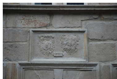
Armoiries bûchées et la date 1587 (ou 1582 ?). Phot. Simone Hartmann-Nussbaum IVR82_20124202584NUCA
