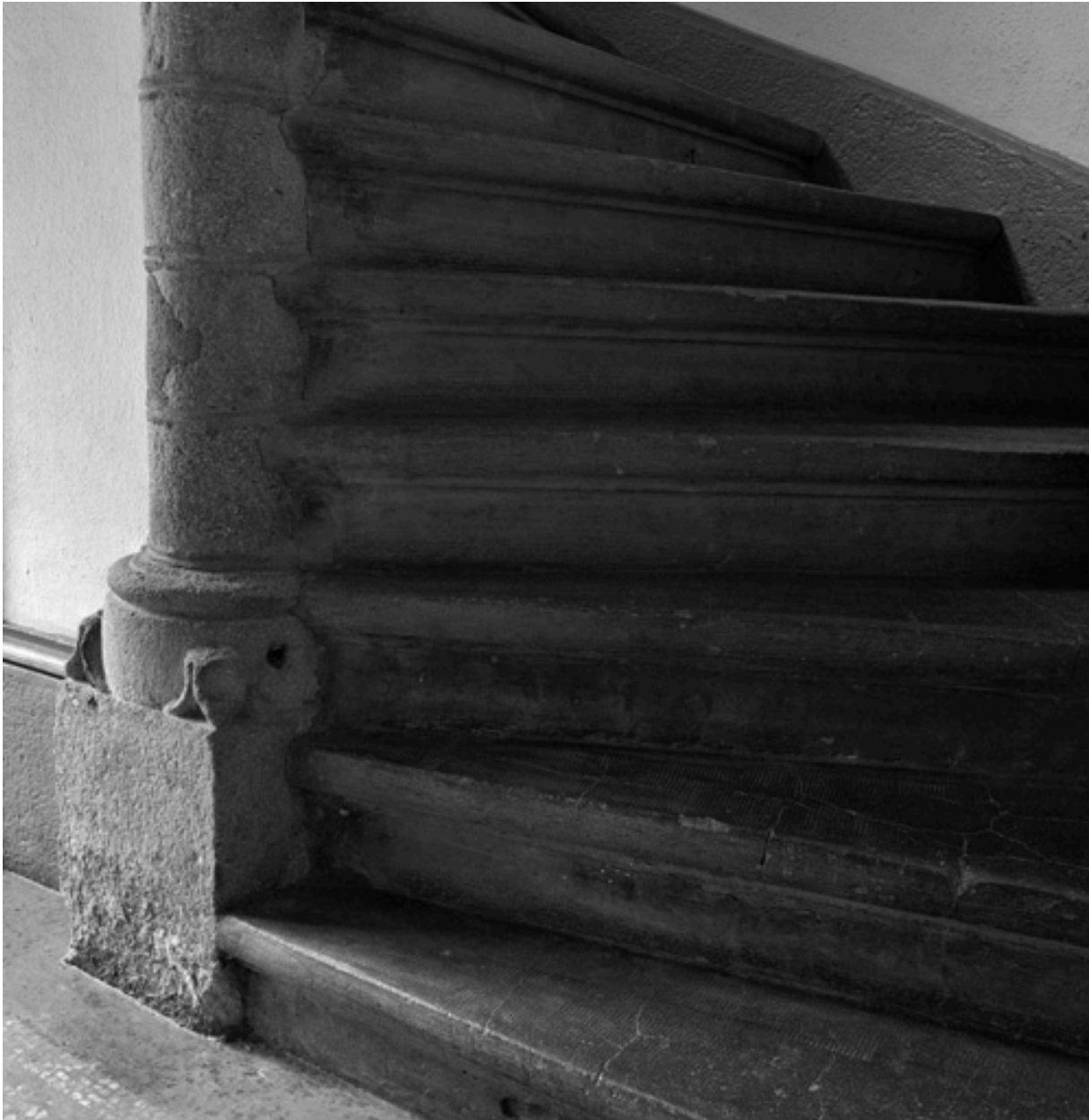
Départ de l'escalier en vis.
