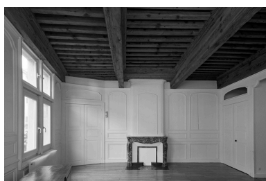
Vue de la chambre : cheminée avec manteau en marbre, menuiseries du 4e quart du 19e siècle. Phot. Eric Dessert IVR82_20064200570V
