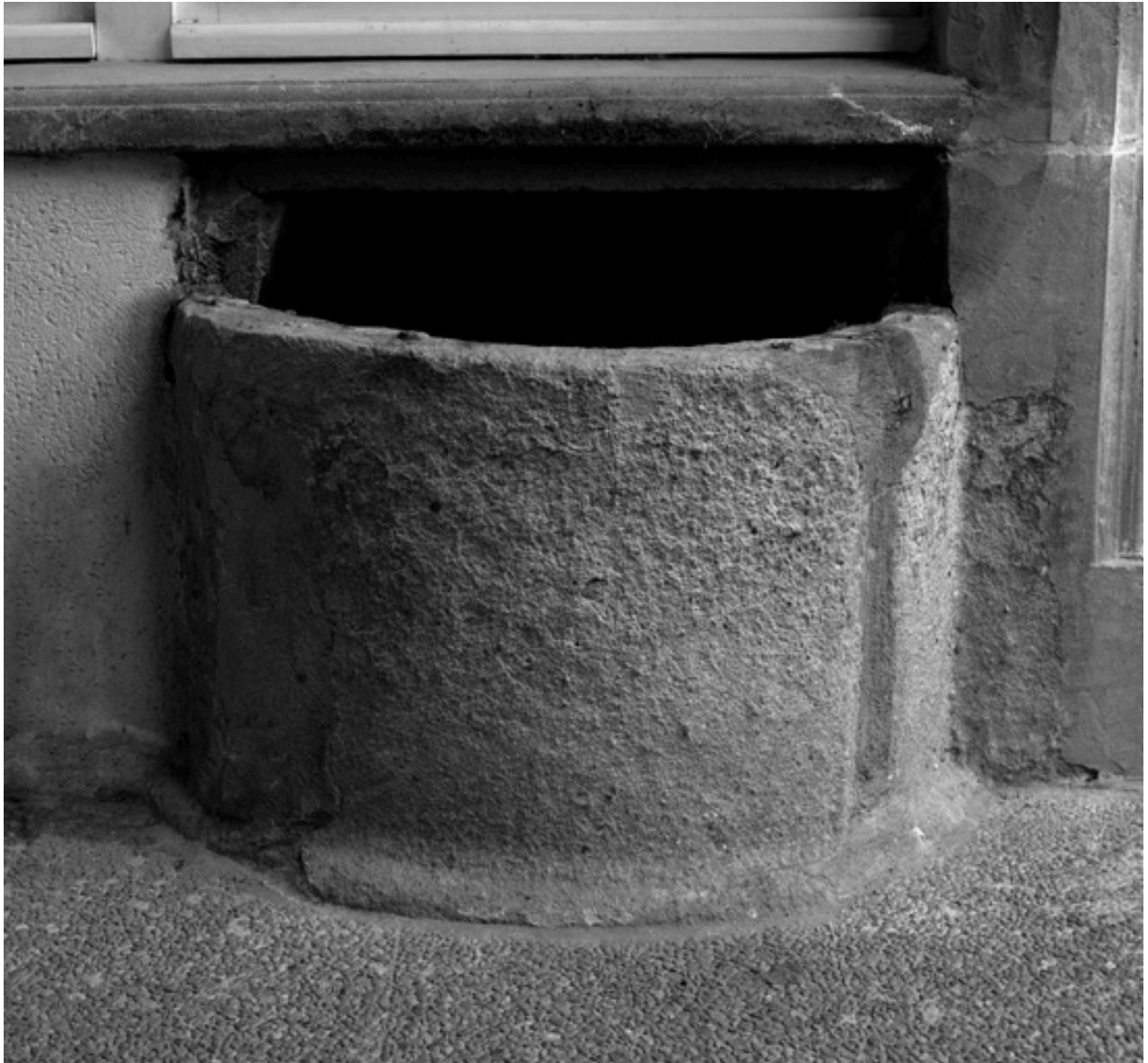
Puits demi-circulaire installé dans la cour.
