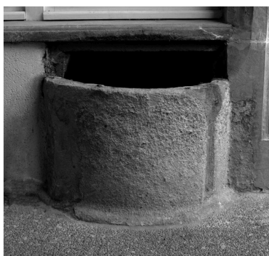
Puits demi-circulaire installé dans la cour. Phot. Eric Dessert IVR82_20064200580NUC
