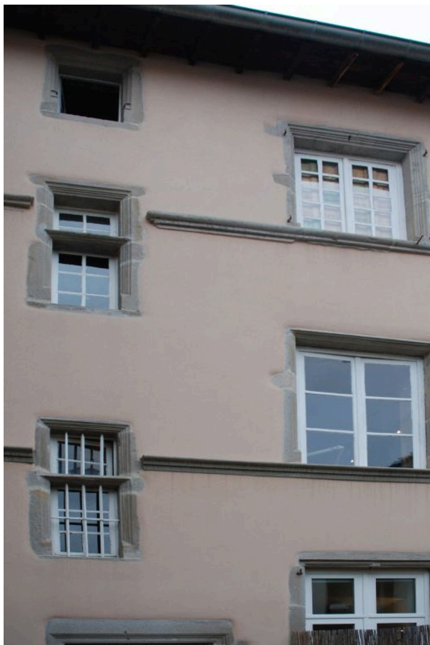
Vue partielle de la travée éclairant la cage d'escalier.
