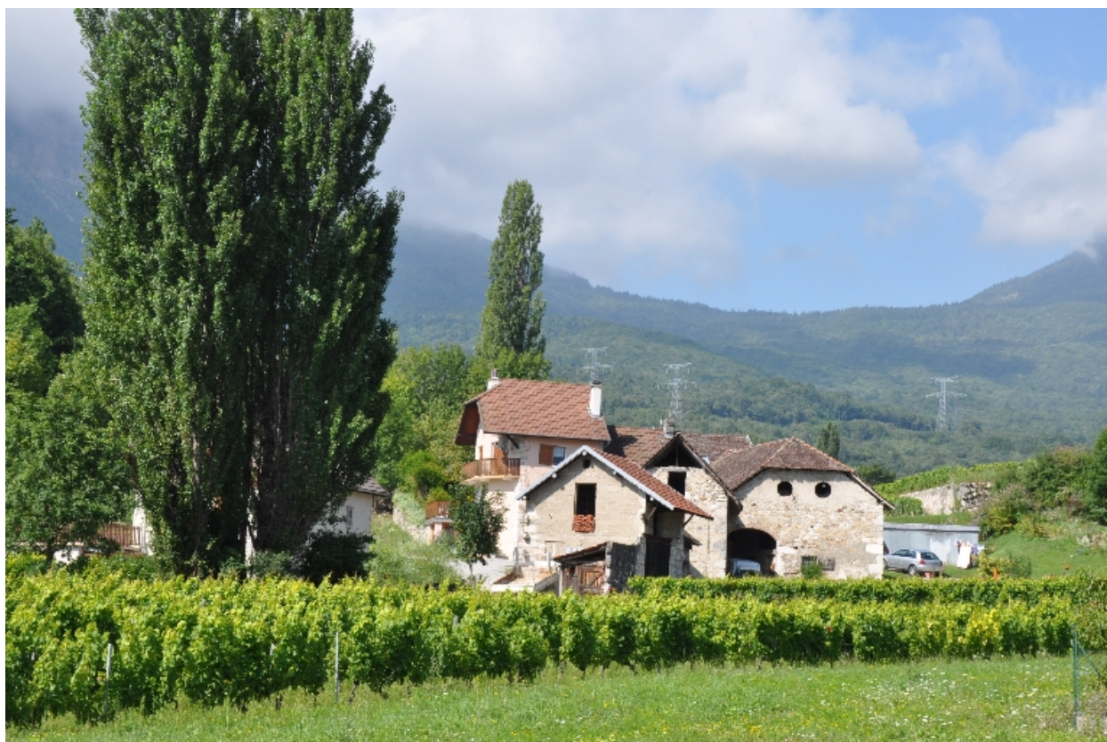
Vue générale des moulins Thevenon.
