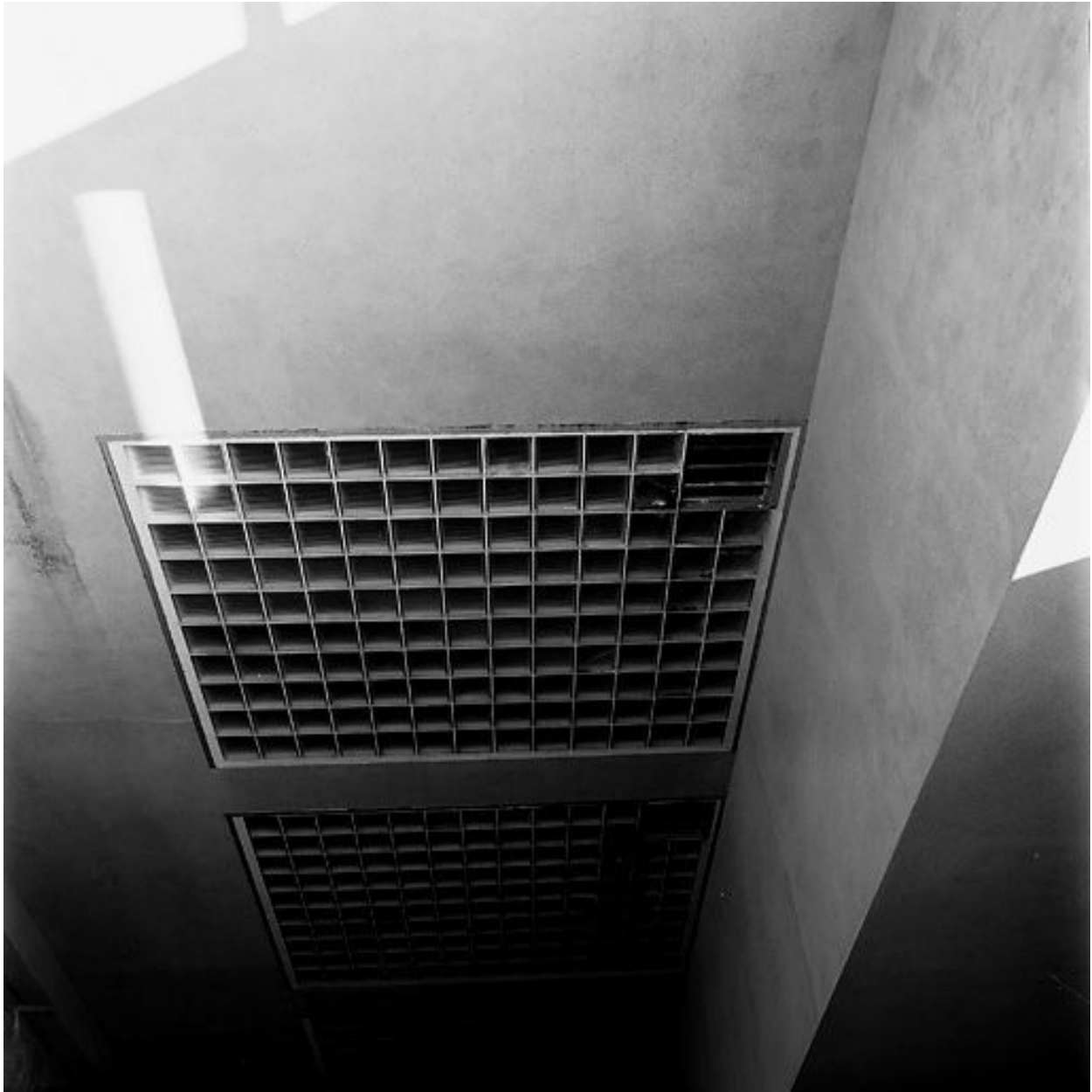
Façade sur cour de la cage d'escalier, côté est, vue depuis la terrasse de l'édifice
