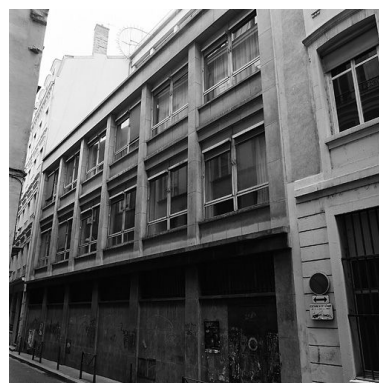
Façade sur la rue Mulet Phot. Didier Gourbin IVR82_20036902092X
