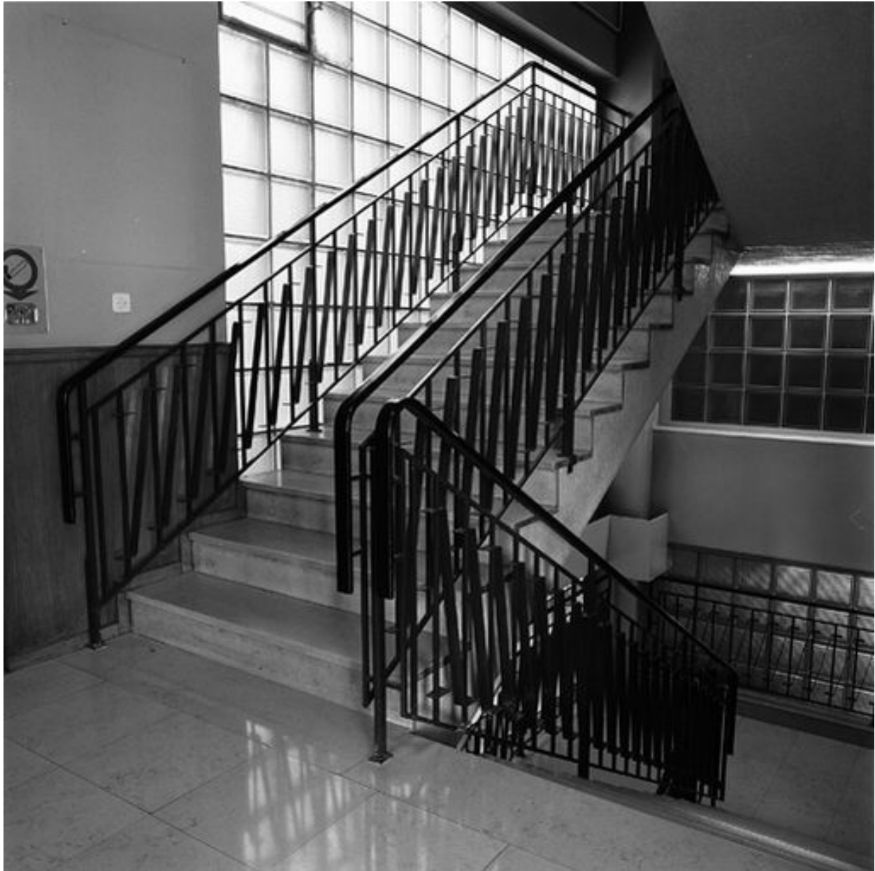
Escalier vu depuis le palier du 5e étage
