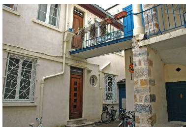
Façade ouest sur cour depuis l'angle nord-ouest de la cour Phot. Maryannick Chalabi IVR82_20066901308NUCA
