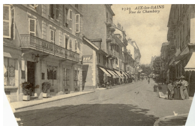
Vue prise du sud Repro. François Fouger IVR82_20077300441NUCB
