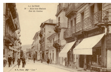
Vue d'ensemble Repro. François Fouger IVR82_20057300971NUCB
