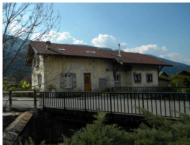
Vue d'ensemble avec extension au nord. Phot. Jérôme Daviet IVR82_20107402747NUCA
