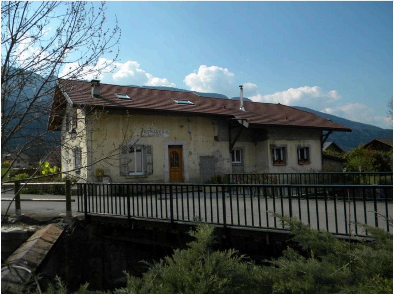
Vue d'ensemble avec extension au nord.
