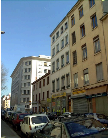
Façade sur rue, vue générale Phot. Bernard Ducouret IVR82_20016900847NUCA
