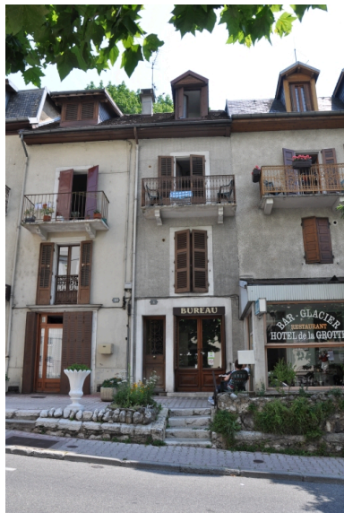
Façade ouest Phot. François Fouger IVR82_20107301278NUCA
