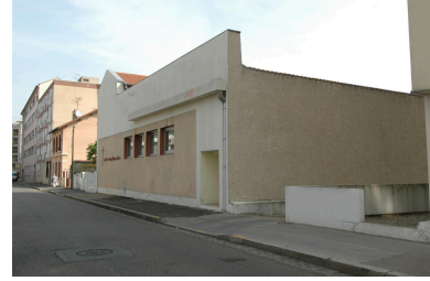
Vue est du site Phot. Nadine Halitim-Dubois IVR84_20186901443NUCA
