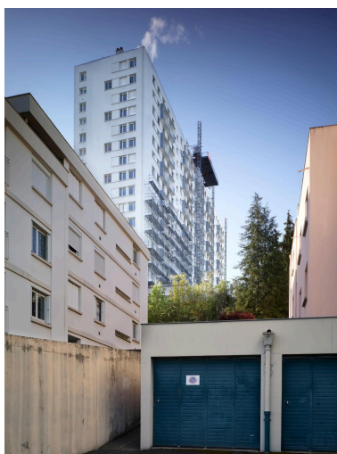
Vues générales des bâtiments du Secteur industrialisé. Immeuble dit Allée des Dômes, en avril 2021 : en cours de déconstruction. Phot. Christian Parisey IVR84_20216300037NUC4A
