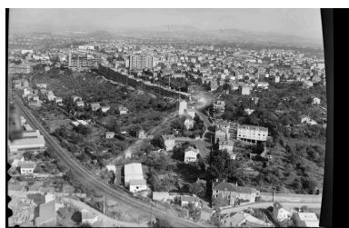
La Muraille de Chine et l'immeuble de l'Allée des Dômes, au fond, en construction, depuis le nord-ouest, avec la voie ferrée au premier plan. Photographie aérienne de Léon Gendre, [1959]. Phot. Service de numérisation des AD du Puy-de-Dôme IVR84_20216300021NUCA
