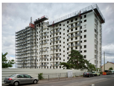
Immeuble de l'allée des Dômes, en cours de déconstruction, au 30 juin 2021. Phot. Christian Parisey IVR84_20216301233NUC4A
