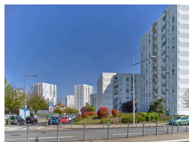
Vues générales des bâtiments du Secteur industrialisé. Troisième tranche du Secteur industrialisé. Au premier plan, boulevard Louis-Loucheur, limite initiale dudit Secteur. Phot. Christian Parisey IVR84_20216300044NUC4A
