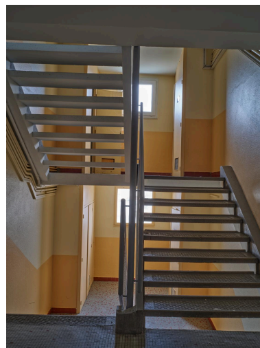
Intérieurs, espaces de distribution. Immeuble du 1-3 allée des Dômes. Cage d'un des deux escaliers, palier du 13e étage. Phot. Christian Parisey IVR84_20206301024NUC4A
