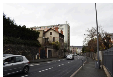
Points de vue. Avenue Léon-Blum (ancienne avenue d'Aubière), qui marque une des limites à l'est de l'emprise du Secteur industrialisé. Immeubles 104 et 105 de la première tranche (peints en rose, blanc et gris). Au loin, on distingue les tours de la cathédrale de Clermont-Ferrand, point culminant du centre ancien. (Photo chercheur.) Phot. Bénédicte Renaud-Morand IVR84_20206301049NUCA
