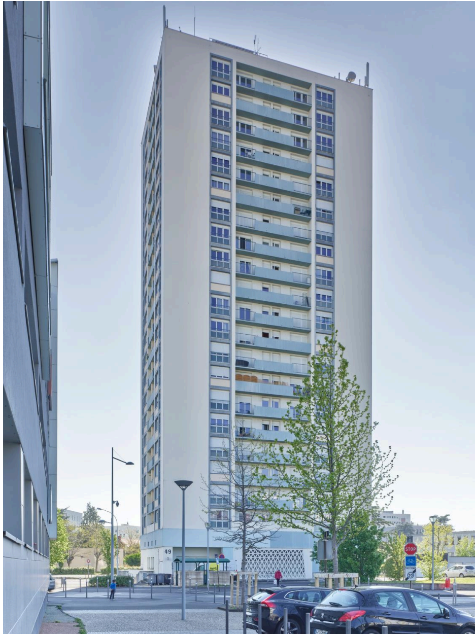
Vues générales des bâtiments du Secteur industrialisé. L'immeuble en forme de tour (TGH).
