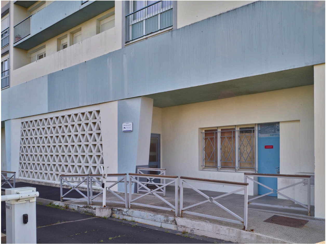
Espaces de transition (entre extérieur et intérieur des immeubles). La TGH. Détail de l'espace de transition menant à l'entrée commune.
