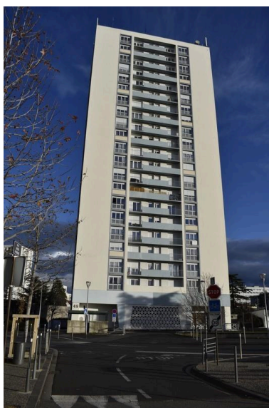
Vues générales des bâtiments du Secteur industrialisé. La tour de grande hauteur (20 étages) du grand ensemble Saint-Jacques nord, 2e tranche, située au 49 rue des Liondards. (Photo chercheur.) Phot. Bénédicte Renaud-Morand IVR84_20206301037NUCA
