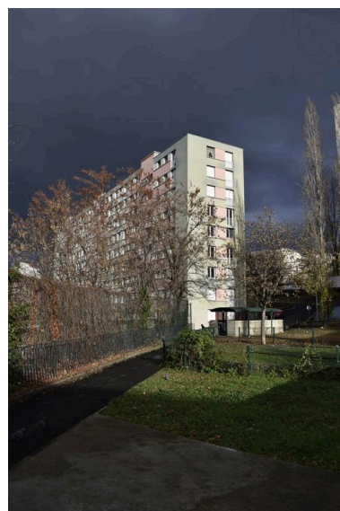
Vues générales des bâtiments du Secteur industrialisé. Immeuble 104, situé 56-60 avenue Léon- Blum, 1ère tranche du Secteur industrialisé. Depuis la rue de la Rotonde. Au premier plan, l'espace vert avec petit muret demi- circulaire en béton, est rattaché à l'immeuble. (Photo chercheur.) Phot. Bénédicte Renaud-Morand IVR84_20206301039NUCA
