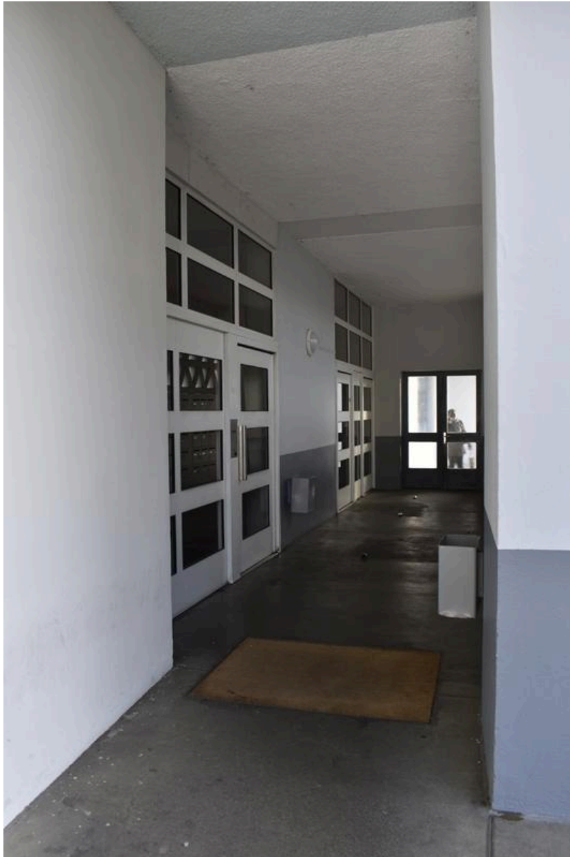
Espaces de transition (entre extérieur et intérieur des immeubles). Tour du 49 rue des Liondards : l'entrée derrière la clastra. (Photo chercheure.)
