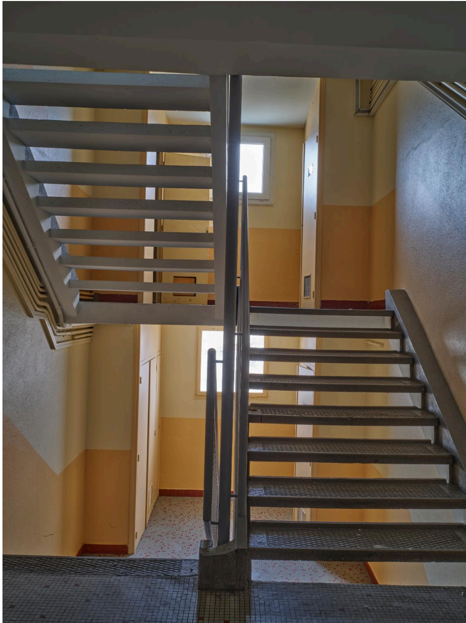
Intérieurs, espaces de distribution. Immeuble du 1-3 allée des Dômes. Cage d'un des deux escaliers, palier du 13e étage.
