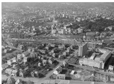
La Muraille de Chine en construction, depuis le sud. Photographie aérienne de Léon Gendre, datant donc probablement de 1959. Phot. Service de numérisation des AD du Puy-de-Dôme IVR84_20216300019NUCA
