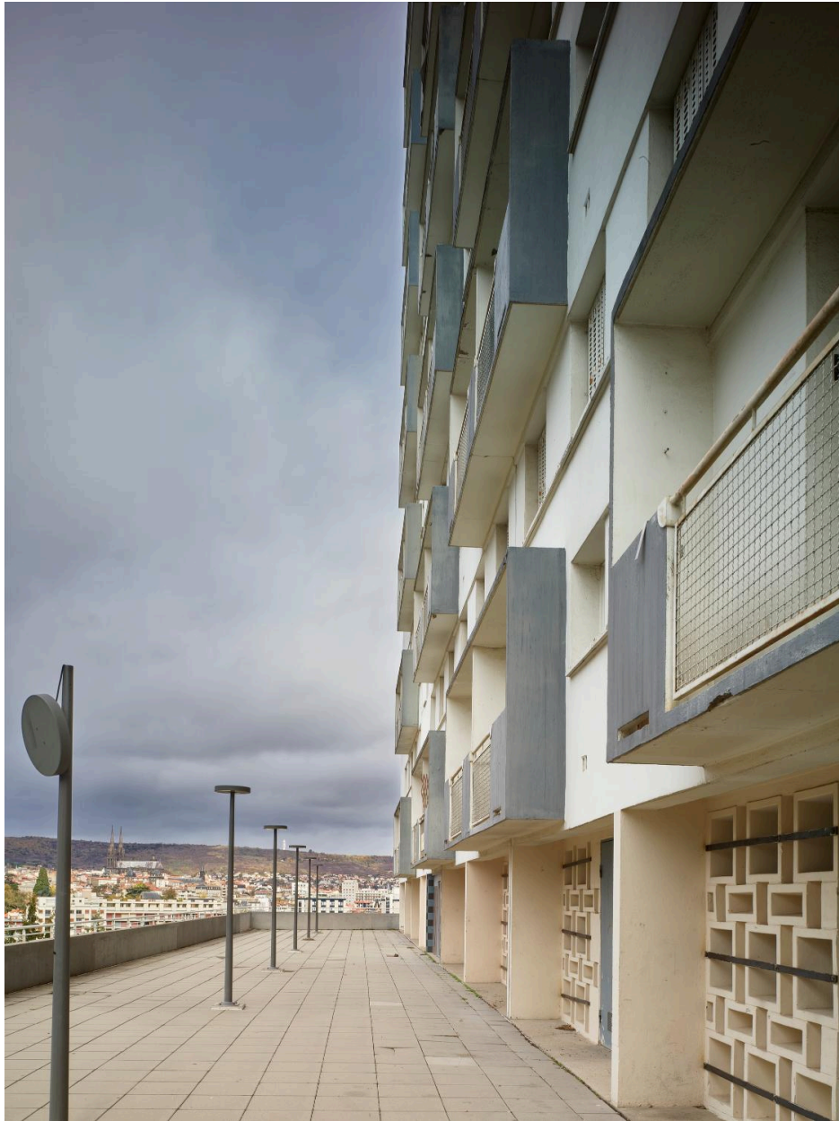
Chemins piétons et points de vue. Dalle de l'immeuble situé au 1-3 allée des Dômes formant belvédère. Au loin, la cathédrale de Clermont-Ferrand et à l'arrière-plan les côtes de Chanturgues (inconstructibles).
