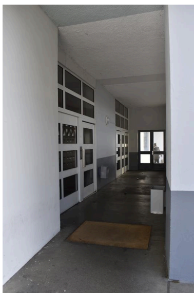
Espaces de transition (entre extérieur et intérieur des immeubles). Tour du 49 rue des Liondards : l'entrée derrière la claustra. (Photo chercheure.) Phot. Bénédicte Renaud-Morand IVR84_20206301056NUCA
