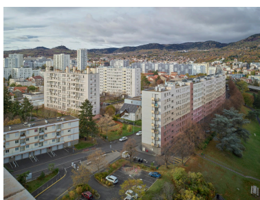
Vue depuis le toit-terrasse de l'immeuble du 1-3 allée des Dômes vers le sud et l'ouest. A droite du cliché, la Muraille de Chine, à l'arrière de laquelle on aperçoit une des maisons préexistantes au Secteur industrialisé, isolée, et, en bleu, l'amorce du centre culturel et social. Phot. Christian Parisey IVR84_20206301018NUCA
