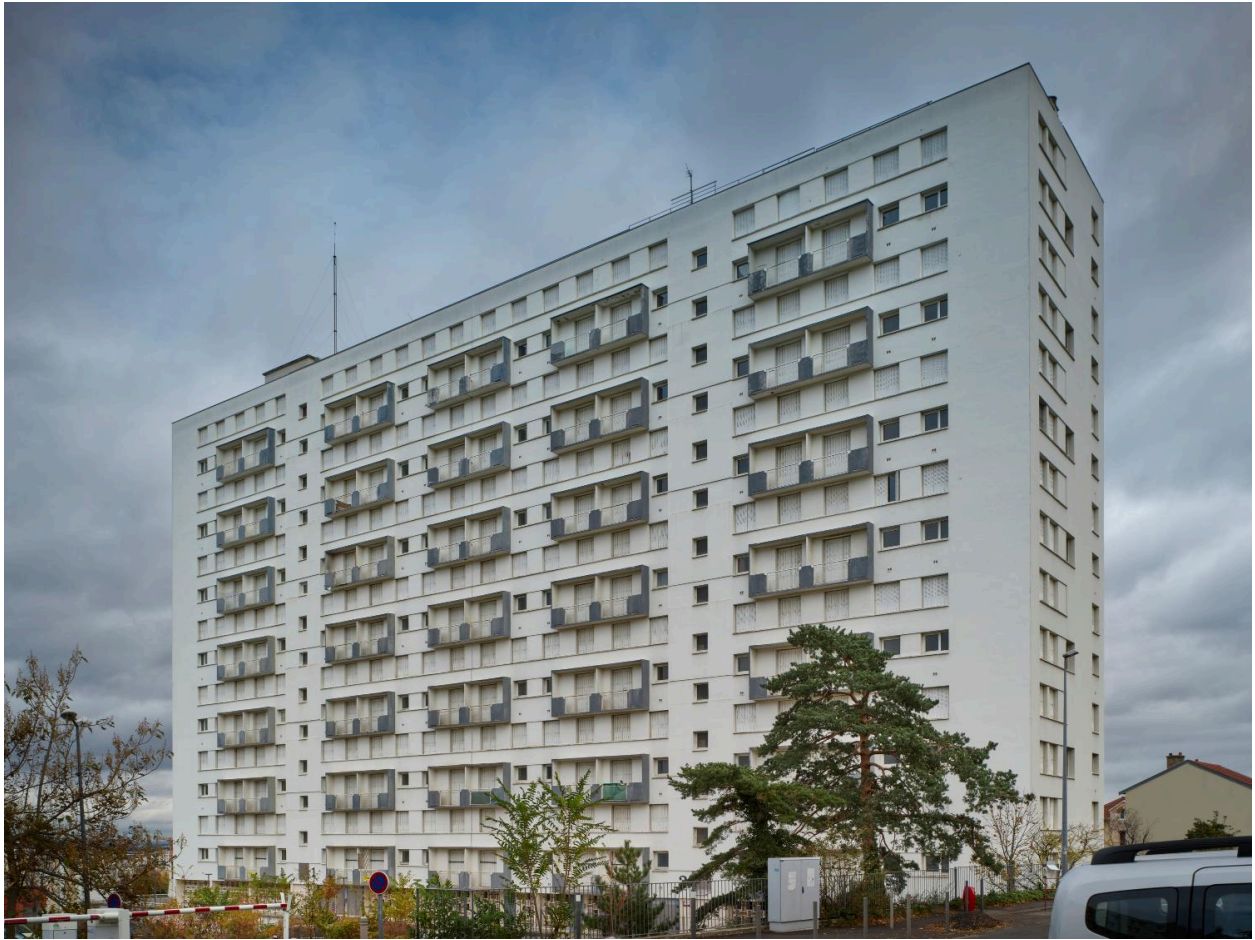
Vues générales des bâtiments du Secteur industrialisé. Vue depuis le sud-ouest de l'immeuble dit Allée des Dômes (Secteur industrialisé, tranche I). Destiné à la démolition (programmée en 2021).
