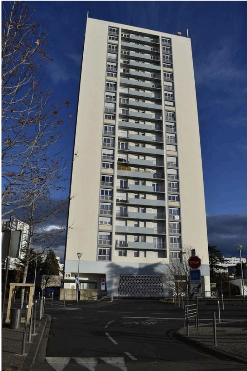
Vues générales des bâtiments du Secteur industrialisé. La tour de grande hauteur (20 étages) du grand ensemble Saint-Jacques nord, 2e tranche, située au 49 rue des Liondards. (Photo chercheur.)
