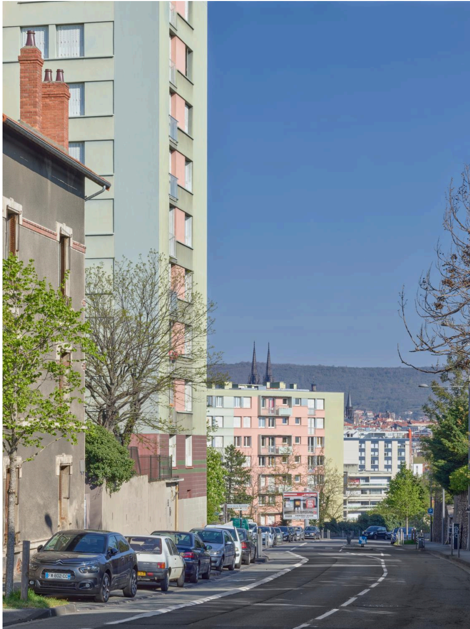
Points de vue. Deux immeubles de la première tranche du Secteur industrialisé et sommet des flèches de la cathédrale de Clermont-Ferrand, au loin.
