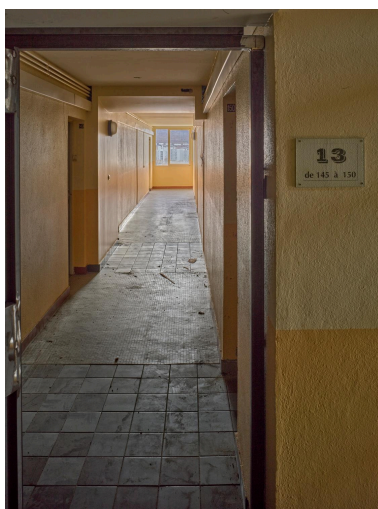
Intérieurs, espaces de distribution. Immeuble du 1-3 allée des Dômes. Couloir de desserte des appartements 145 à 150 du 13e étage. Depuis le palier de l'escalier sud, du nord vers le sud. Phot. Christian Parisey IVR84_20206301023NUCA
