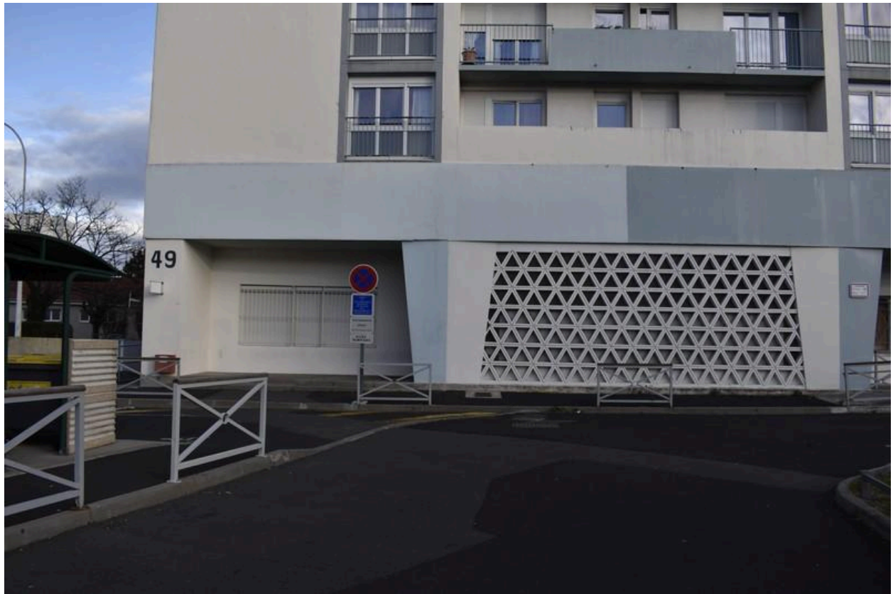
Espaces de transition (entre extérieur et intérieur des immeubles). Tour de grande hauteur (TGH) du 49 rue des Linondards : entrée masquée par une claustra. (Photo chercheure.)
