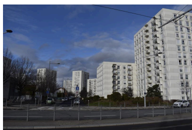
Vues générales des bâtiments du Secteur industrialisé. Immeubles de la tranche III. Depuis le boulevard Louis-Loucheur (limite sud dudit secteur). (Photo chercheur.) Phot. Bénédicte Renaud-Morand IVR84_20206301058NUCA
