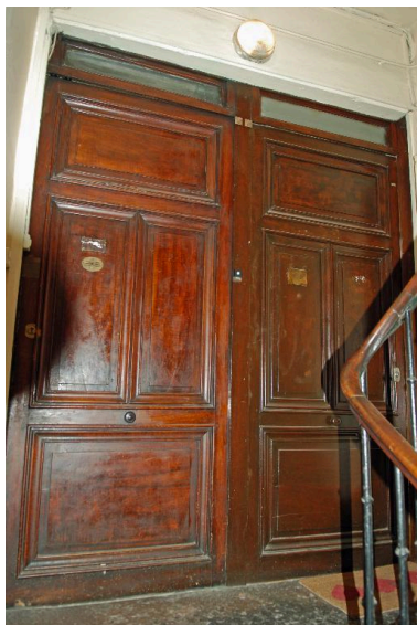
Vue intérieure : porte palière Phot. Magali Delavenne IVR82_20146902871NUCA
