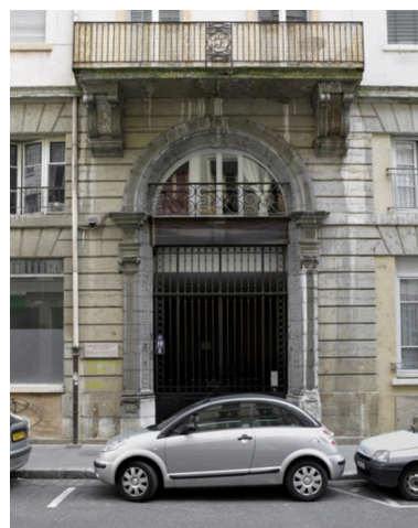
Portail : vue générale Phot. Eric Dessert IVR82_20086901046NUCA
