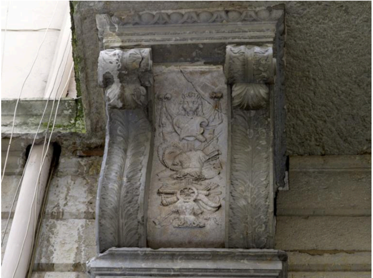
Portail : balcon, console gauche, vue de face
