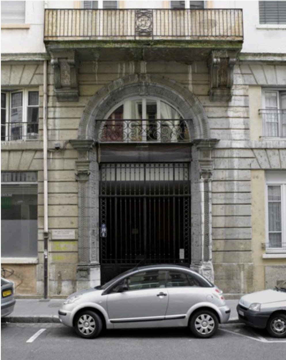
Portail : vue générale
