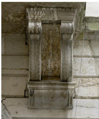
Portail : balcon, console droite, vue de face Phot. Eric Dessert IVR82_20086901047NUCA
