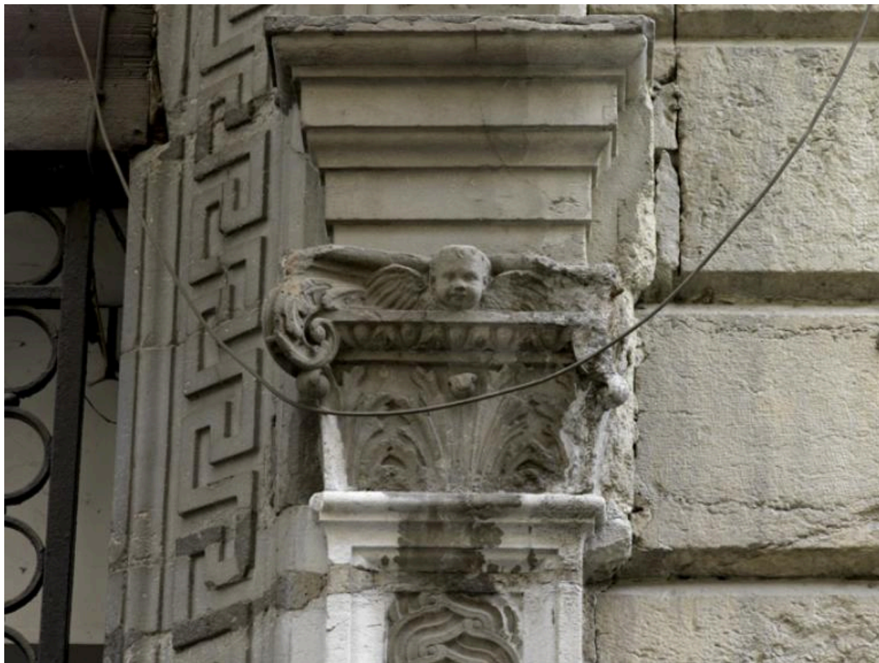
Portail : chapiteau ornant le piédroit droit
