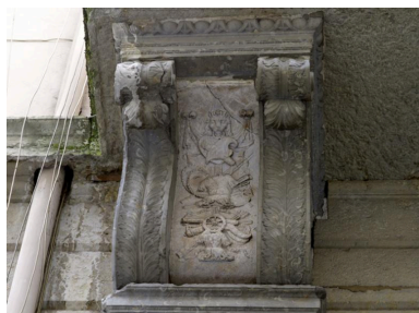
Portail : balcon, console gauche, vue de face Phot. Eric Dessert IVR82_20086901054NUCA
