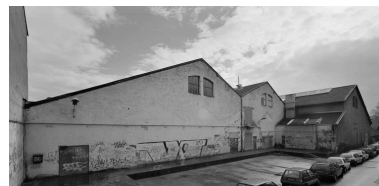
Ateliers quais de déchargement en alignement sur la rue du Repos Phot. Didier Gourbin IVR82_20066900083V
