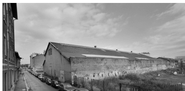
Ateliers en alignement sur la voie ferrée Phot. Didier Gourbin IVR82_20066900082V
