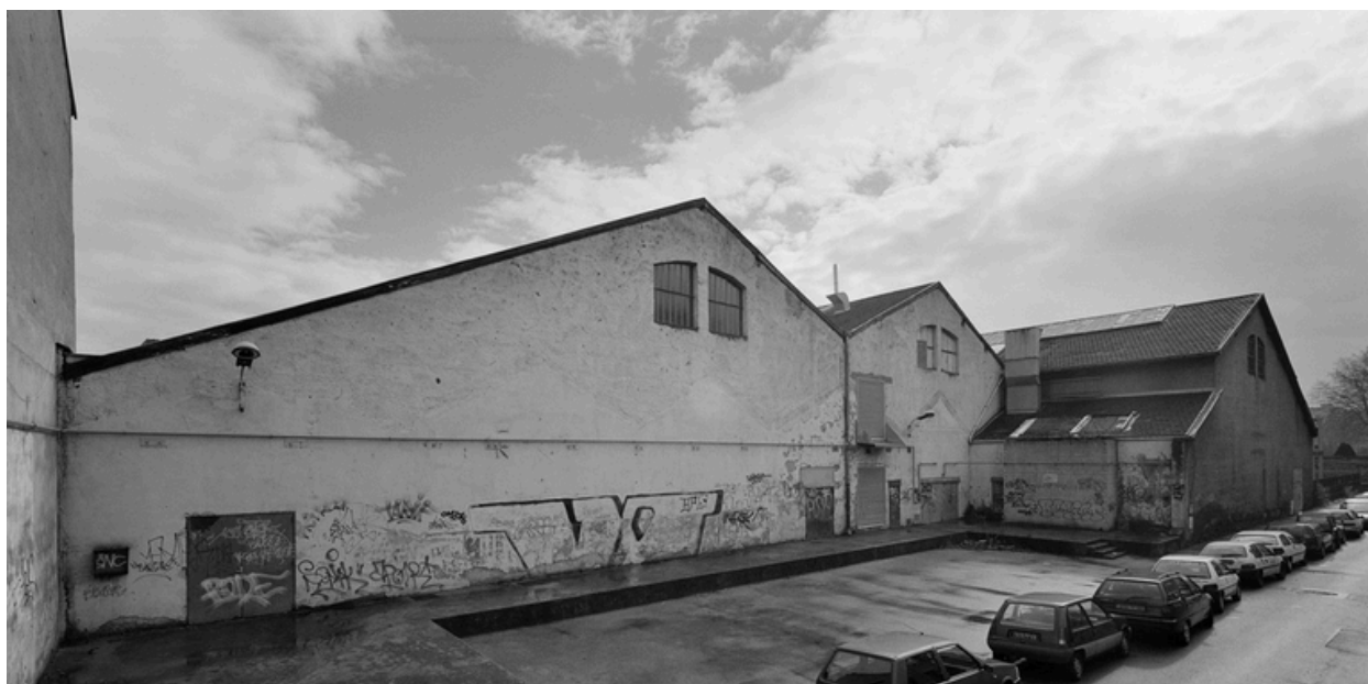
Ateliers quais de déchargement en alignement sur la rue du Repos
