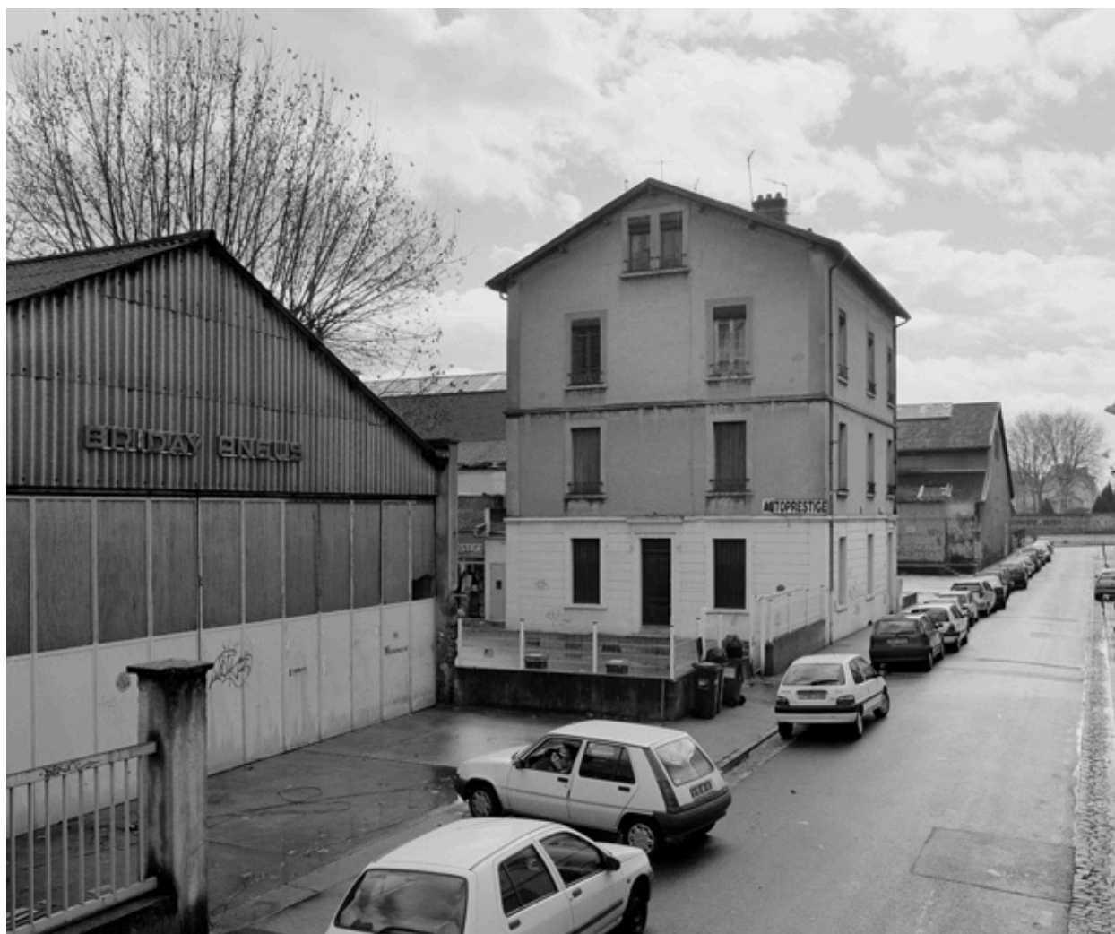
Bâtiment rue du Repos
