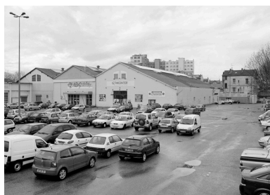
Vue générale nord-est Phot. Didier Gourbin IVR82_20066900072X
