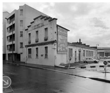
Bâtiment administratif Phot. Didier Gourbin IVR82_20066900070X
