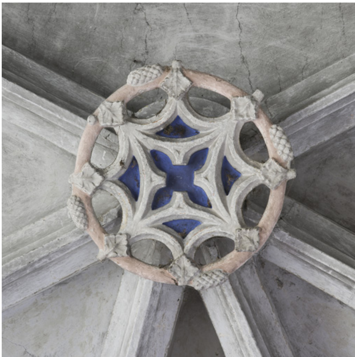
Vue de la clef de voûte n°1.
