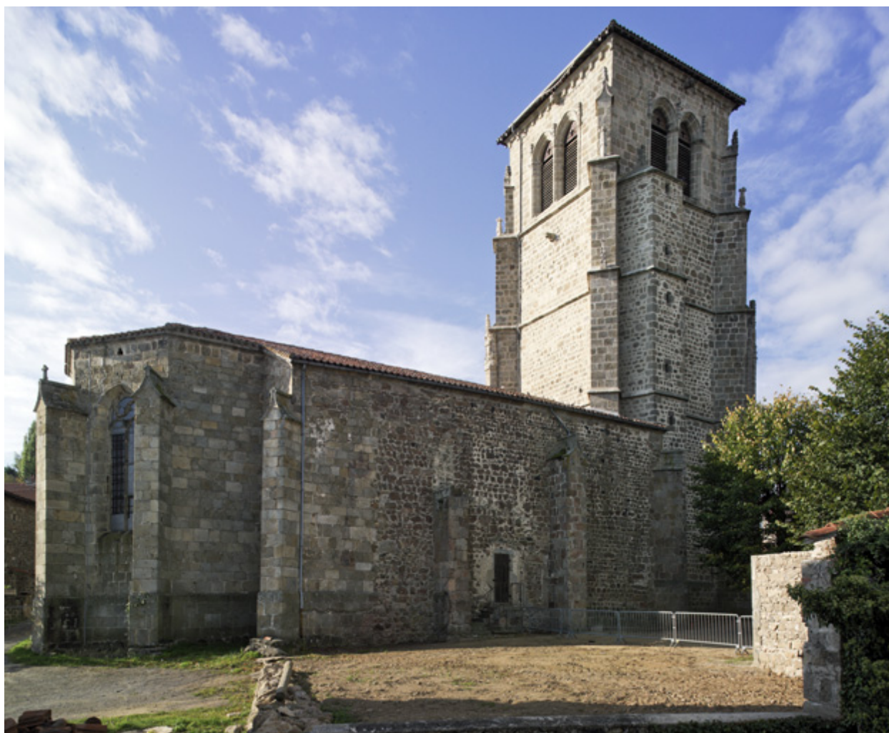
Vue d'ensemble de la façade nord.
