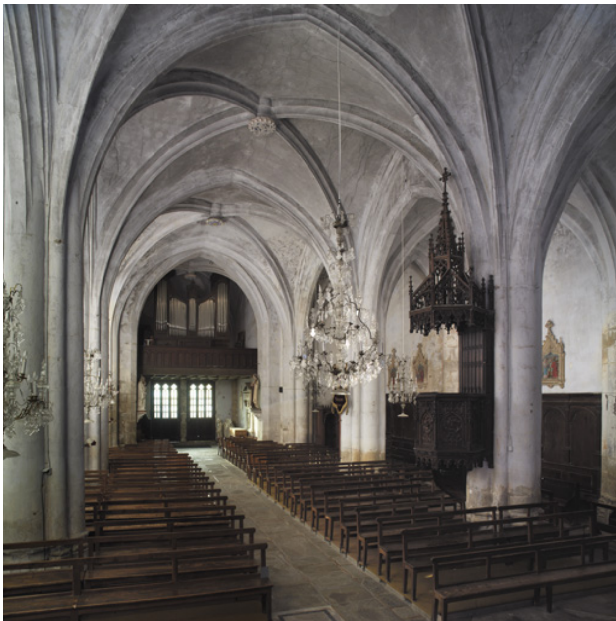
Vue d'ensemble intérieure vers l'entrée, de trois-quarts, du sud-est.
