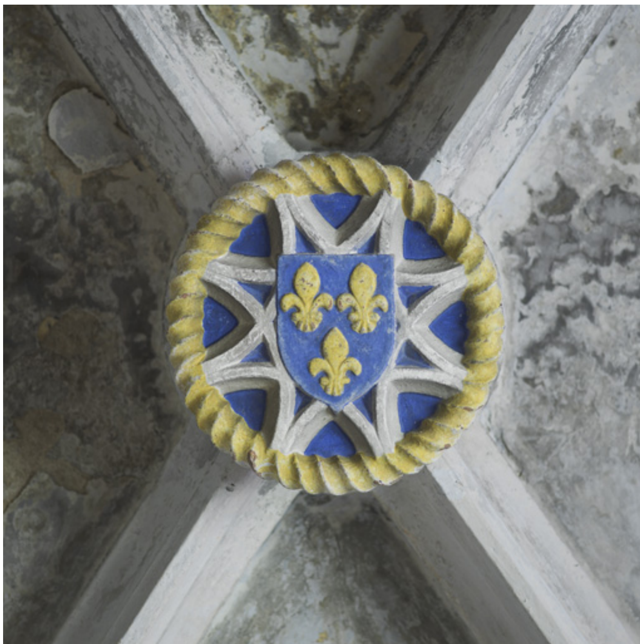
Vue de la clef de voûte n°10.
