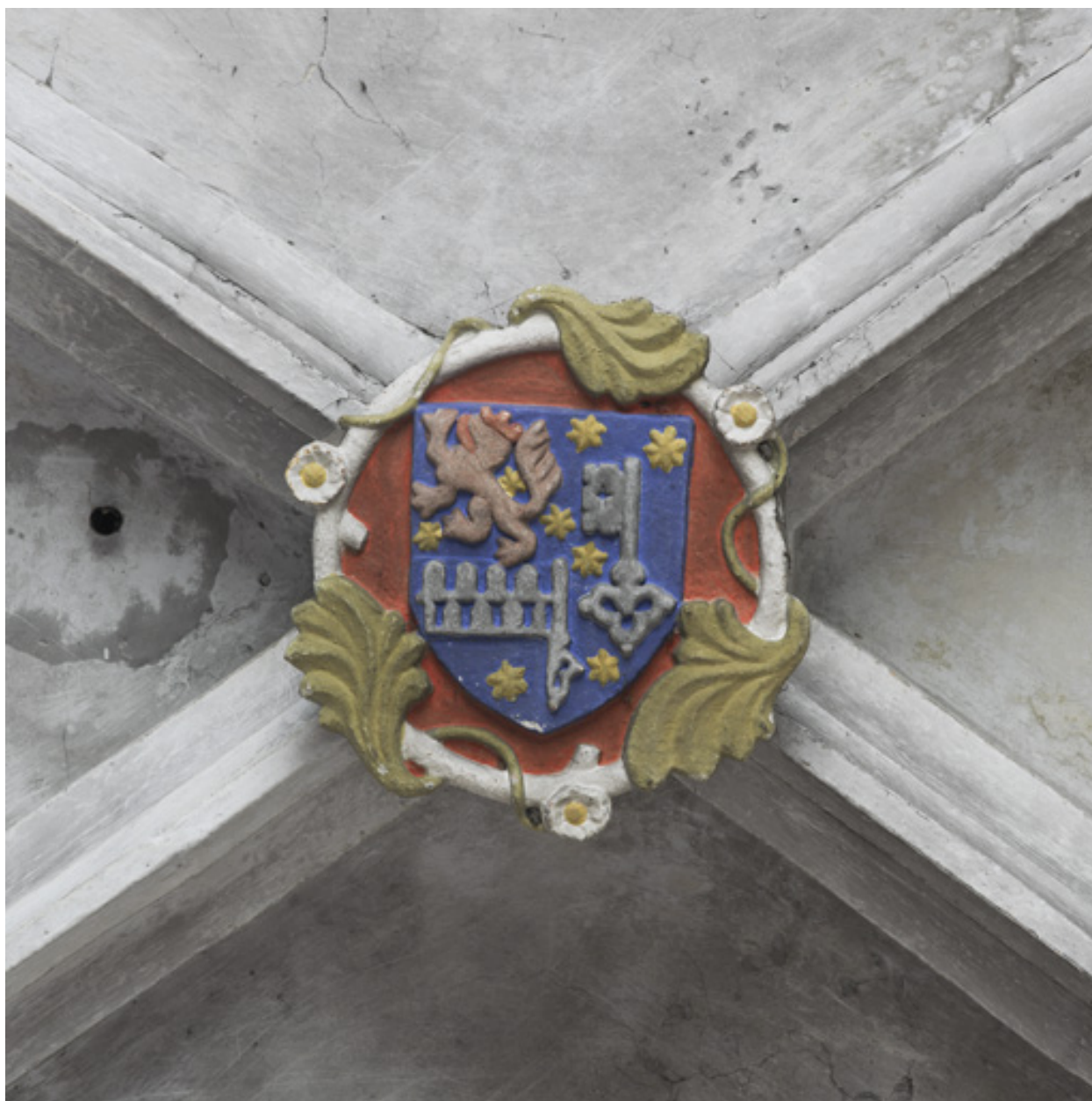
Vue de la clef de voûte n°4.
