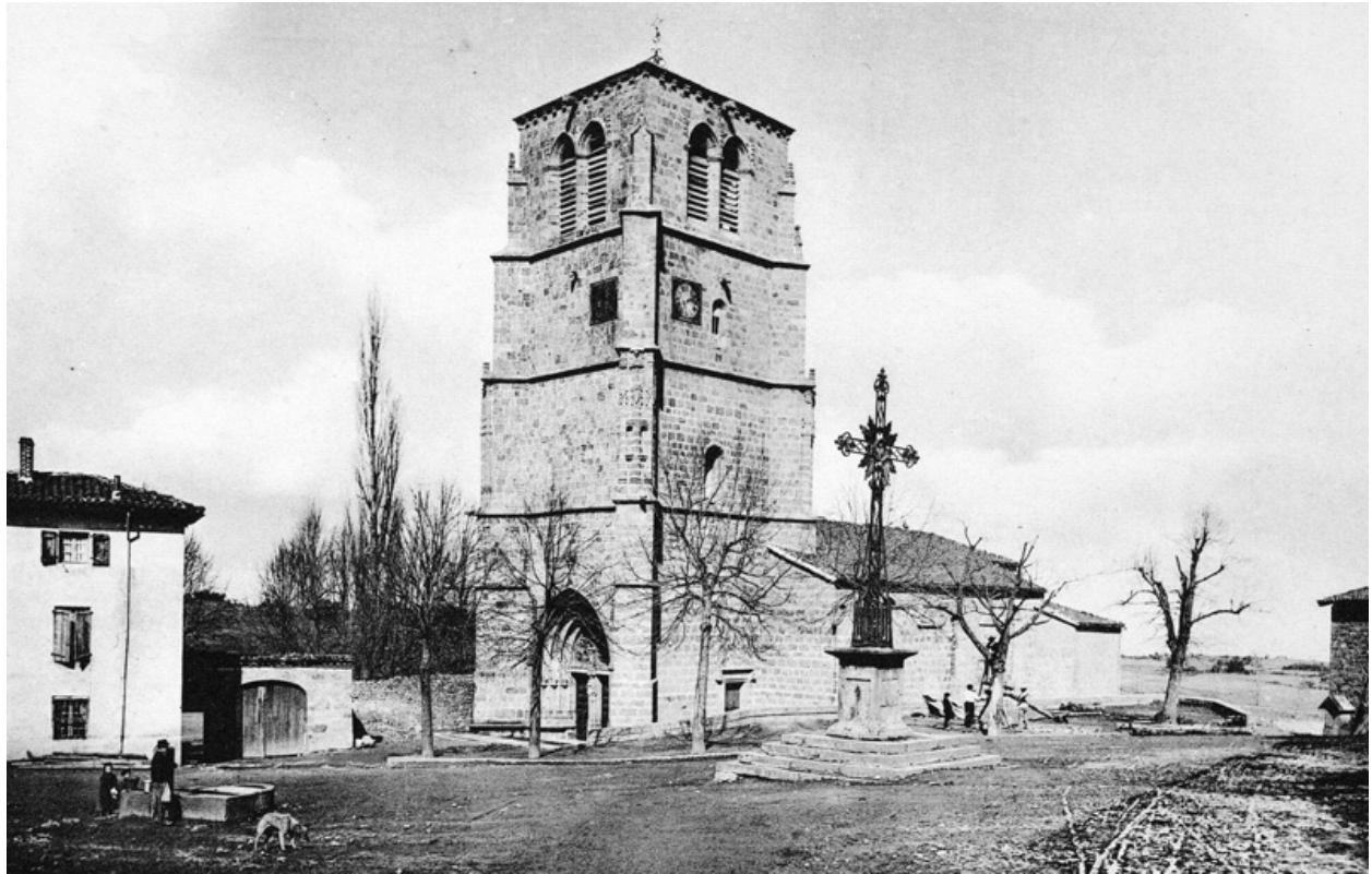
Le Clocher. [Vue d'ensemble de la place et de l'église, du sud-ouest.]
