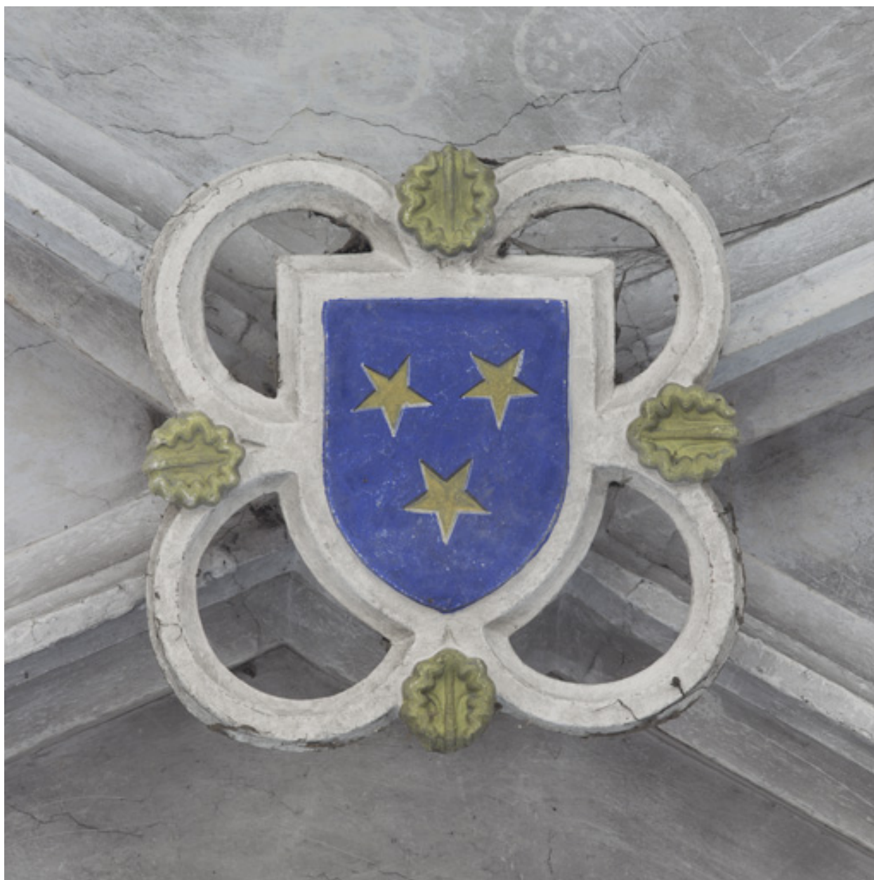
Vue de la clef de voûte n°2.
