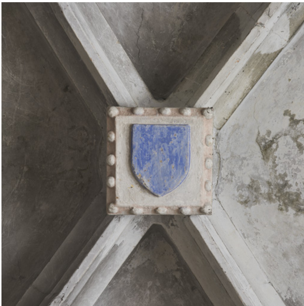
Vue de la clef de voûte n°7.
