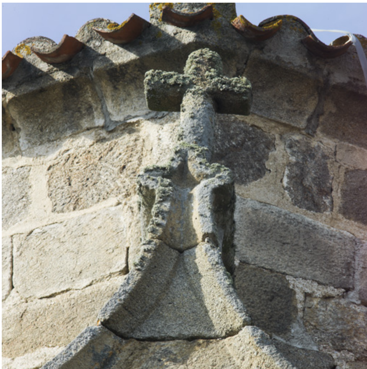
Détail du sommet d'un contrefort du chevet (fond de l'abside, côté nord).
