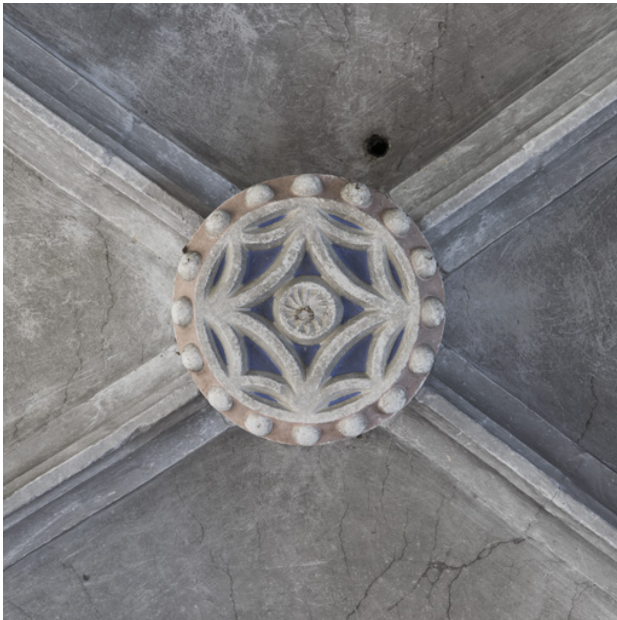
Vue de la clef de voûte n°6.
