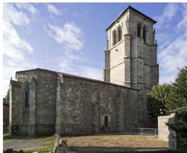
Vue d'ensemble de la façade nord.
