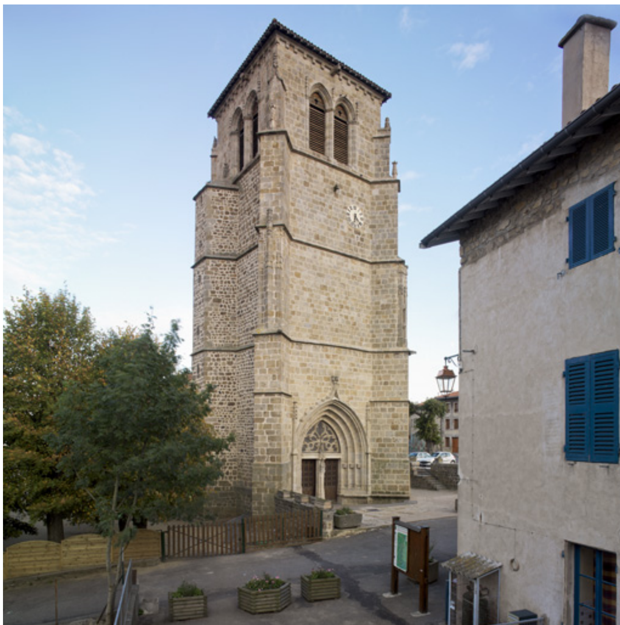
Vue d'ensemble du clocher, de trois-quarts nord-ouest.
