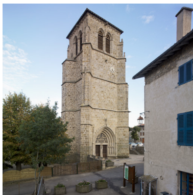
Vue d'ensemble du clocher, de trois-quarts nord-ouest. Phot. Didier Gourbin IVR82_20054202229NUCA
