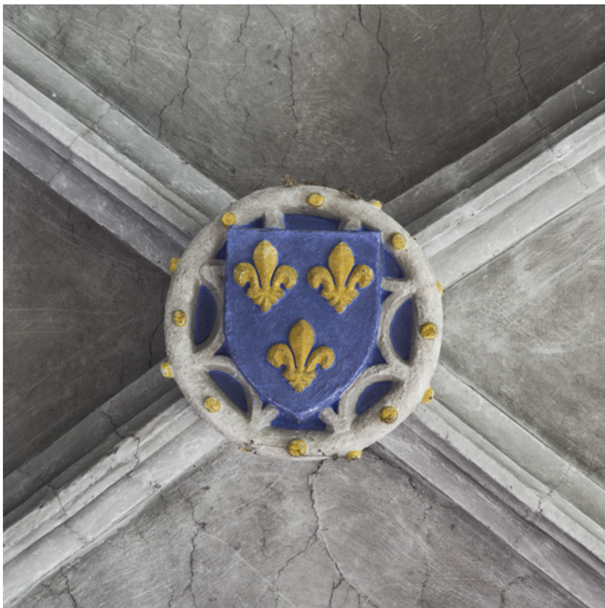
Vue de la clef de voûte n°3.
