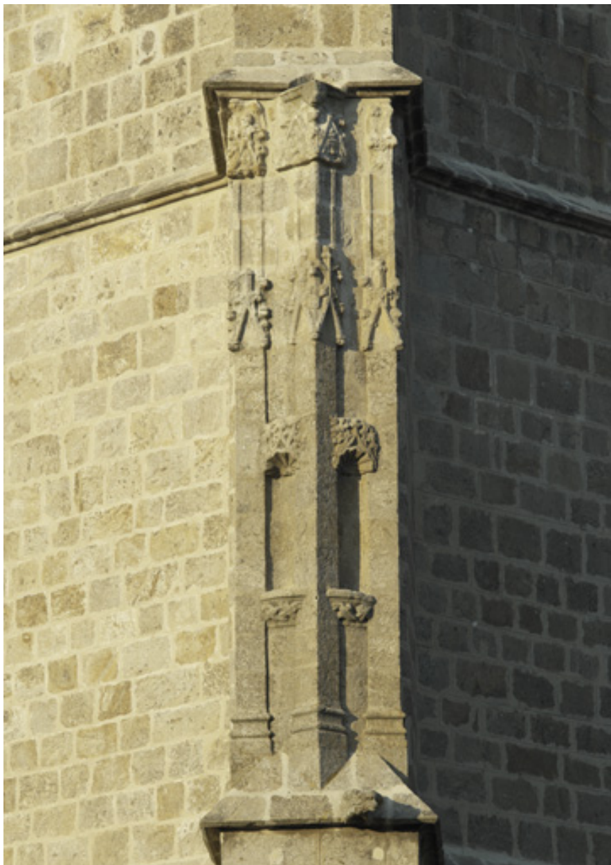
Détail du décor sur un contrefort du clocher.
