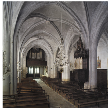
Vue d'ensemble intérieure vers l'entrée, de trois-quarts, du sud-est. Phot. Didier Gourbin IVR82_20054202239NUCA
