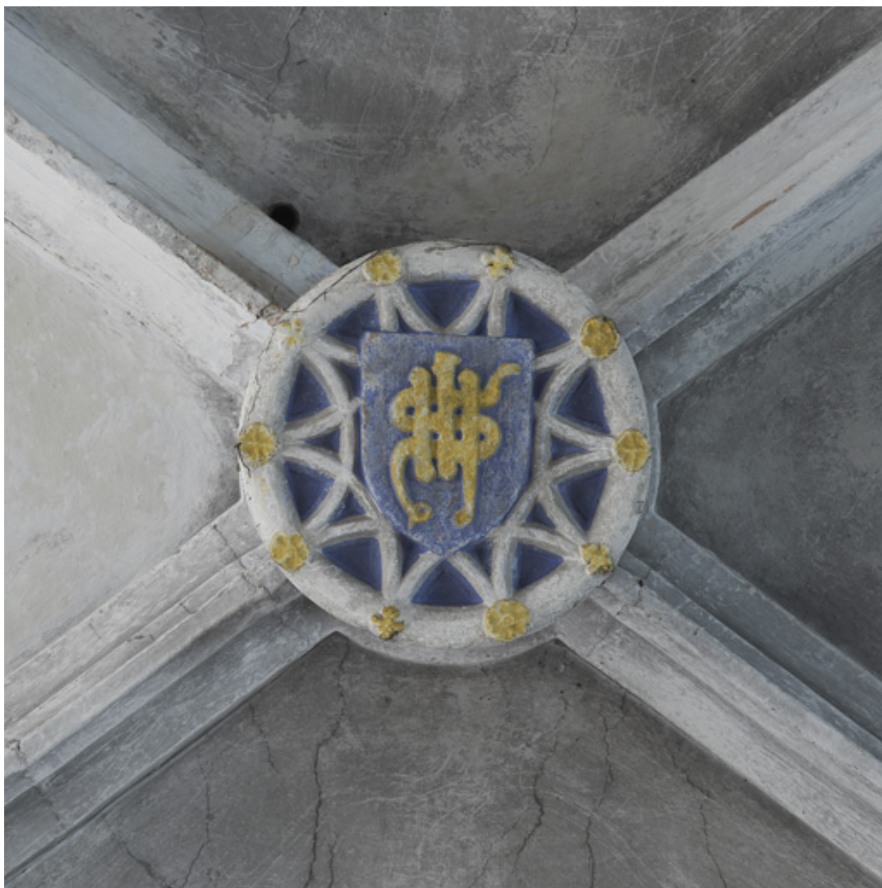
Vue de la clef de voûte n°9.
