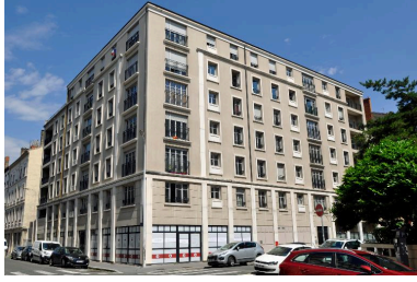
Vue d'ensemble, depuis le sud Phot. Magali Delavenne IVR84_20176901064NUCA
