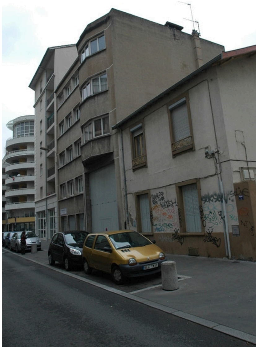
Vue générale sud ouest, rue Etienne Richerand.
