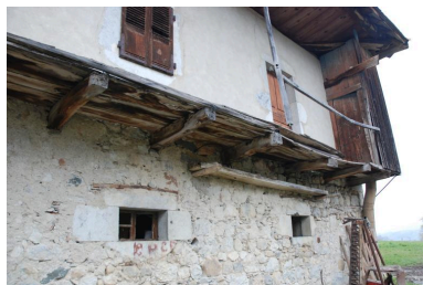
Détail des ouvertures et du balcon-galerie sur le mur pignon sud.
