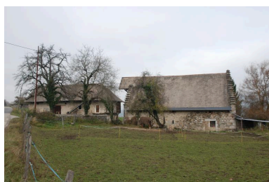
Vue générale depuis le sud-ouest. Phot. Thierry Monnet
