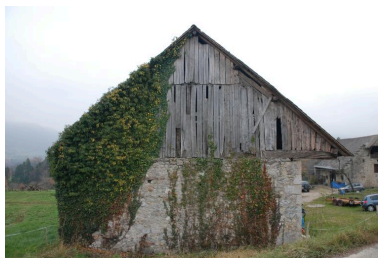
Vue du mur pignon nord.
