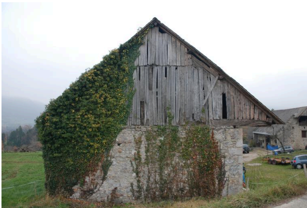
Vue du mur pignon nord.
