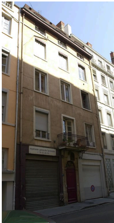
Vue de la façade sur rue Phot. V. Baud IVR82_20046904986NUCA
