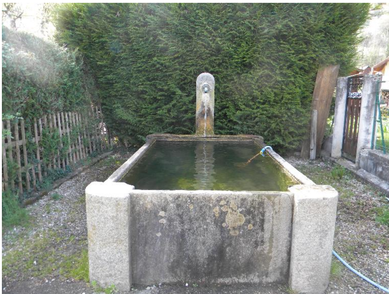
Vue d'ensemble de la fontaine route de Chaparon
