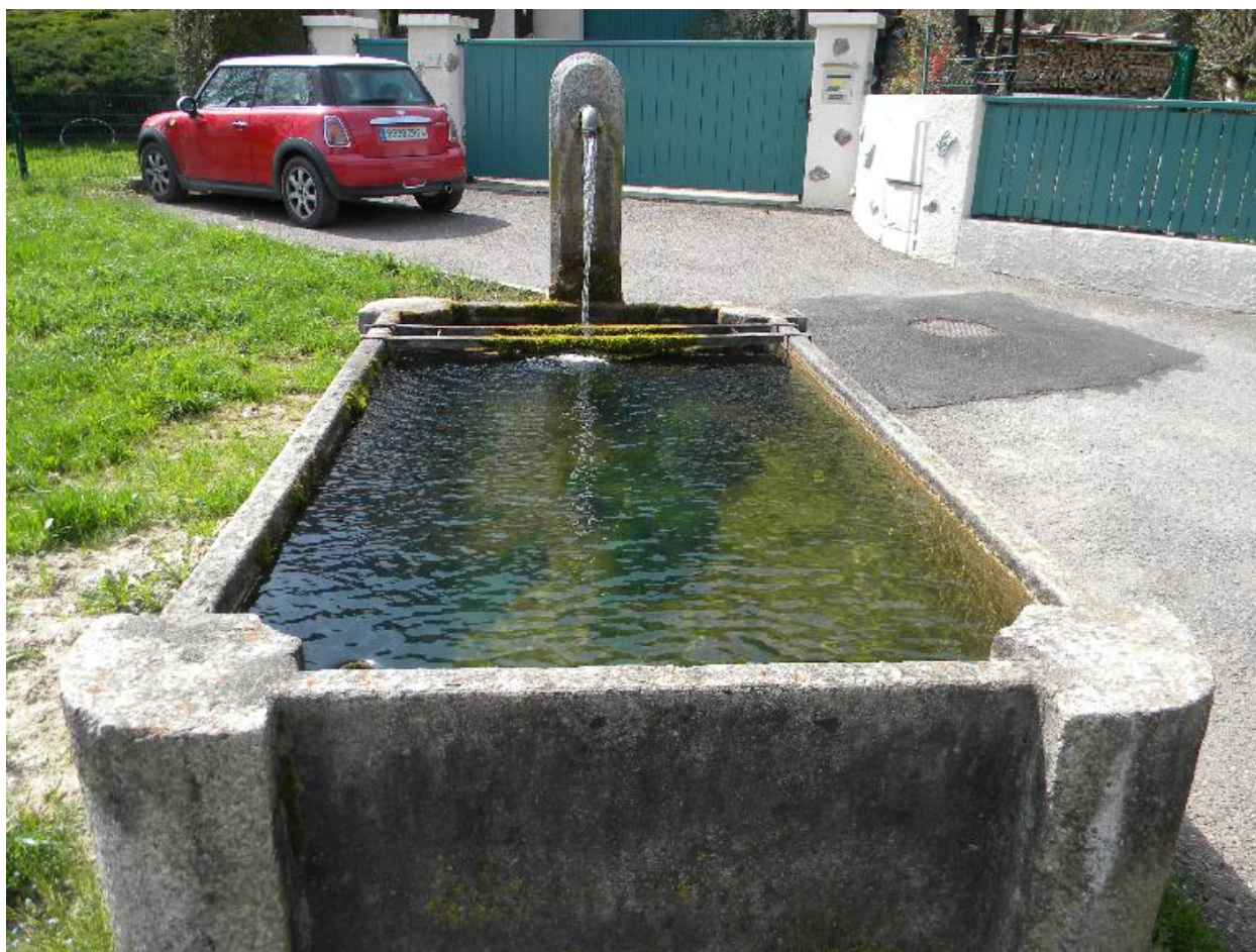
Vue de face du bassin sud du chemin des Fontaines.
