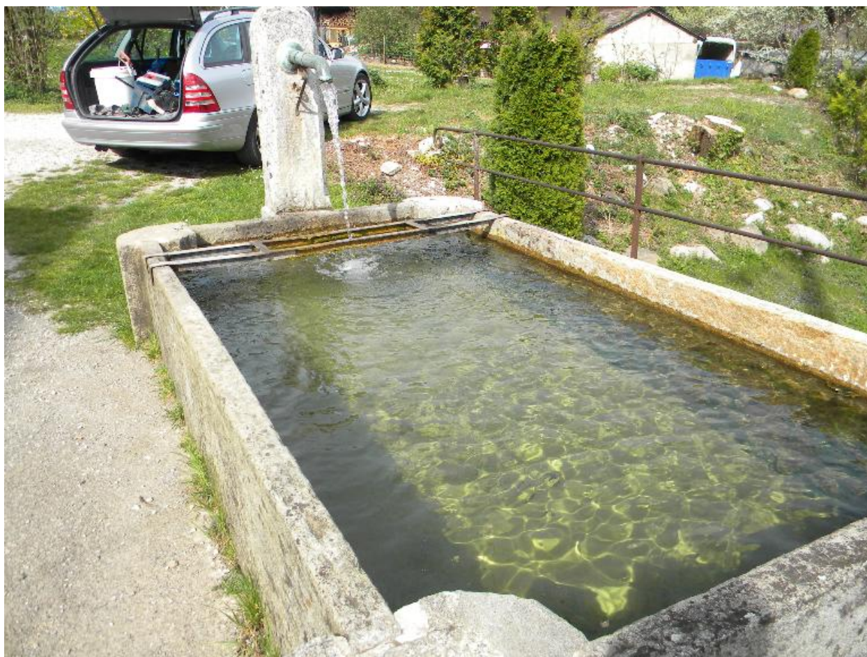
Vue du bassin nord du chemin des Fontaines.
