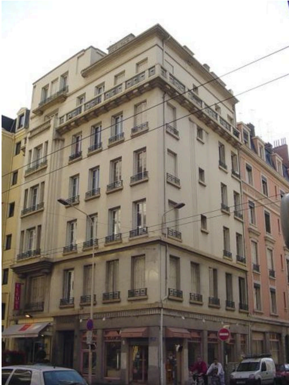
Vue générale de l'élévation
