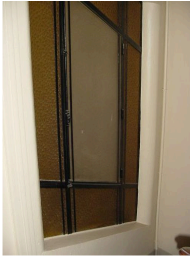
Vitrail éclairant la cage d'escalier Phot. Anaïs Beccaria IVR82_20046903412NUCA
