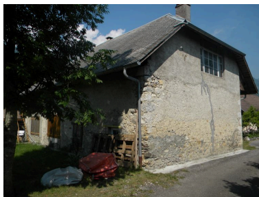
Vue du pignon est et de la façade arrière. Phot. Jérôme Daviet IVR82_20127400537NUCA
