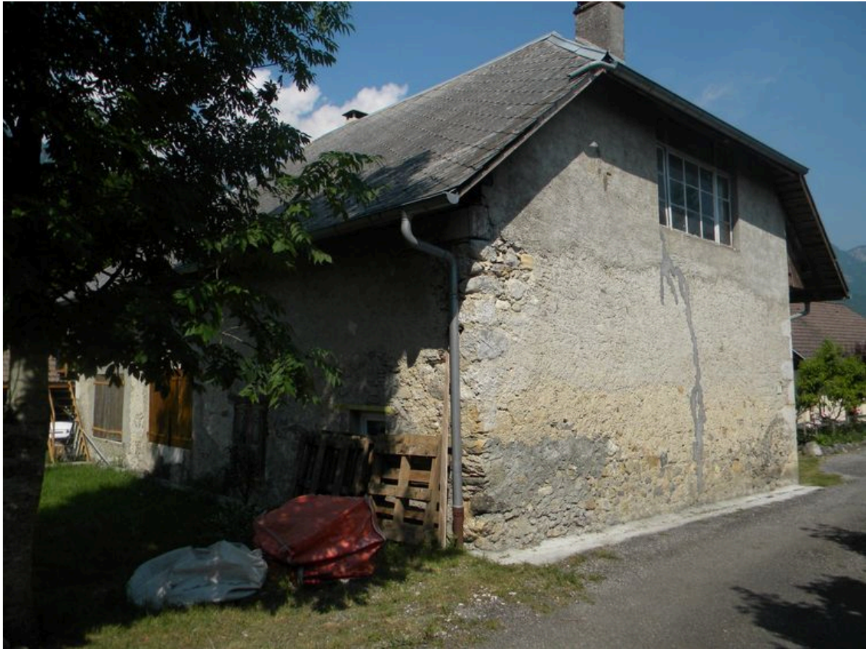
Vue du pignon est et de la façade arrière.
