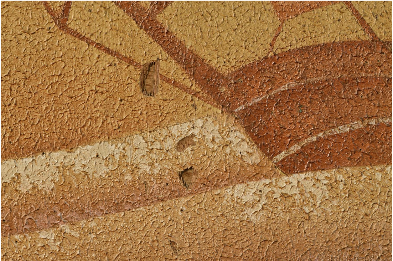
Panneau de droite : éclats de la couche picturale laissant apparaître le support en contre-plaqué
