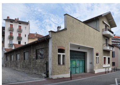
Vue générale du garage Phot. François Fouger IVR82_20117300584NUCA
