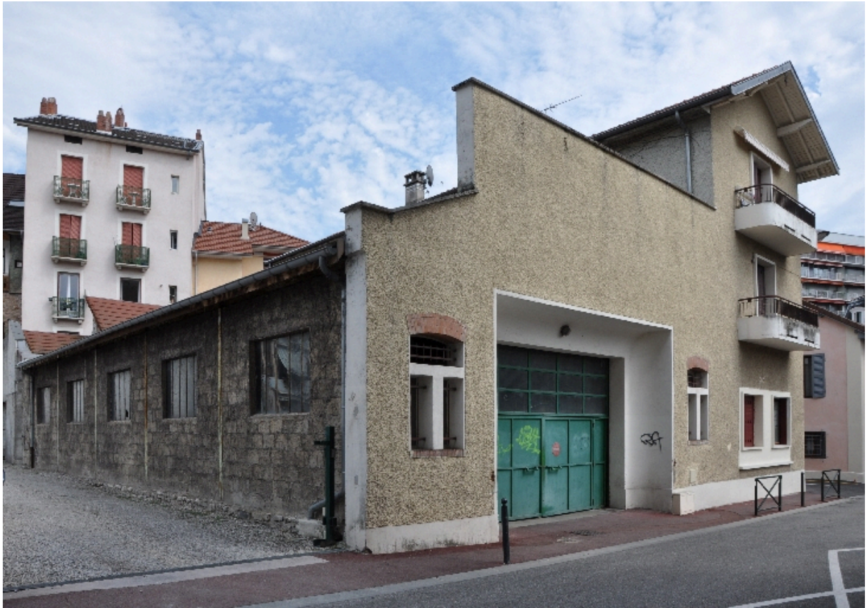
Vue générale du garage
