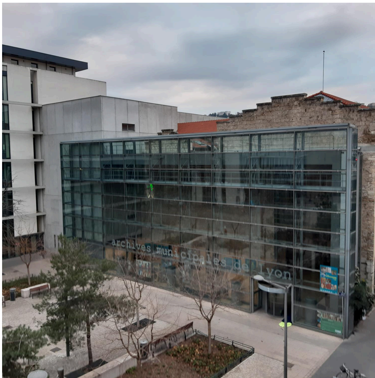
Façade principale des archives municipales de Lyon
