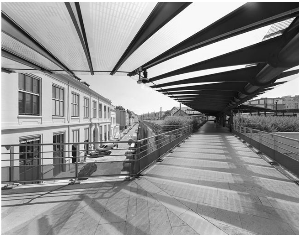
Elévation sur la rue Dugas-Montbel depuis la passerelle SNCF
