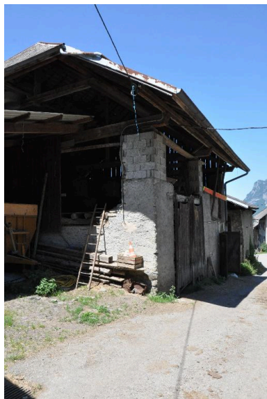
Pignon sud-est du bâtiment. Phot. Clara Bérelle IVR82_20147302553NUCA
