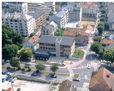
Vue aérienne Repro. François Fouger IVR82_20127300795NUCB
