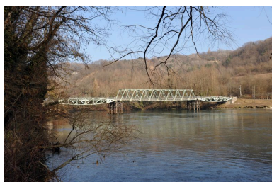
Vue générale, face aval (depuis la rive droite) Phot. G. Gellert IVR82_20100100447NUCA
