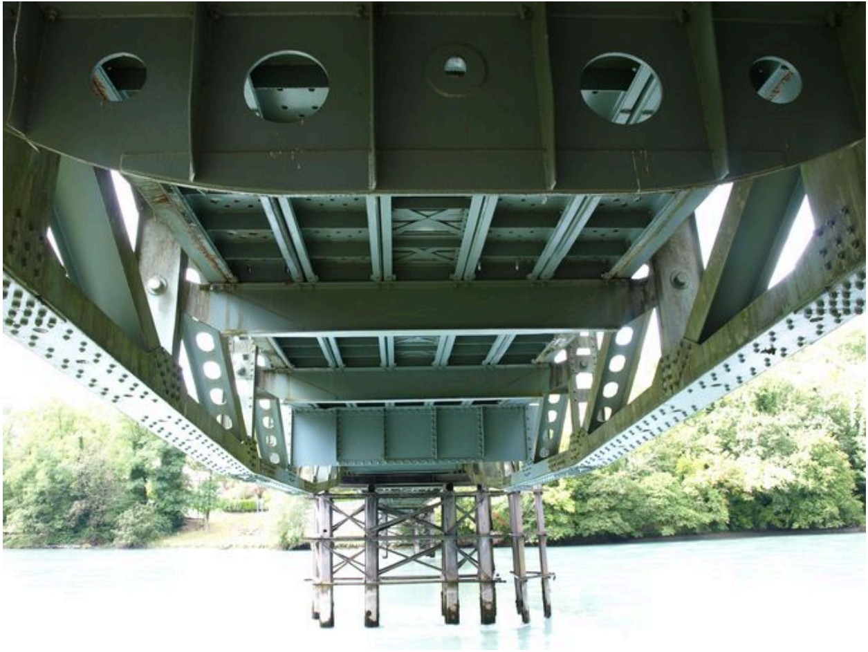
Vue de dessous, travée gauche (depuis la rive gauche)
