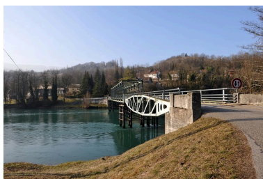
Vue générale, face aval (depuis la rive gauche) Phot. G. Gellert IVR82_20100100450NUCA
