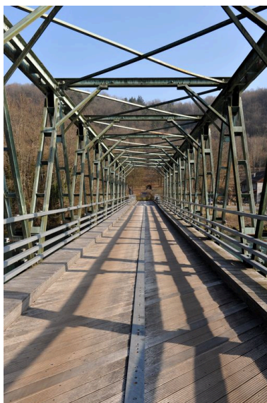
Vue partielle, de dessus, travée centrale (depuis la rive droite) Phot. G. Gellert IVR82_20100100452NUCA
