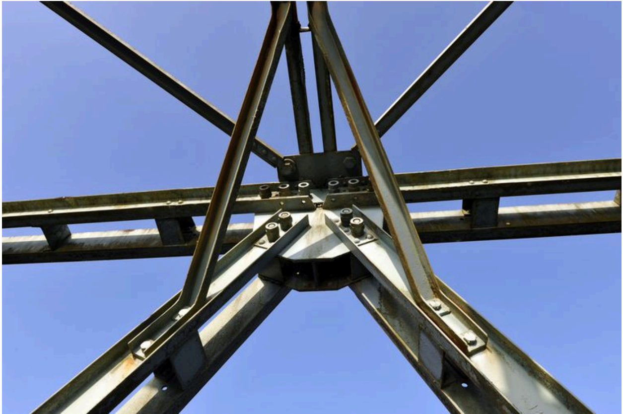
Travée centrale, de dessus, vue de détail : assemblage de la structure métallique, de face
