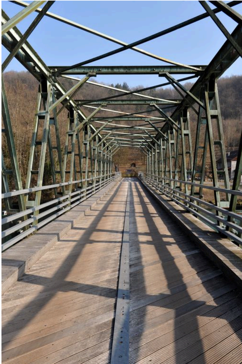
Vue partielle, de dessus, travée centrale (depuis la rive droite)
