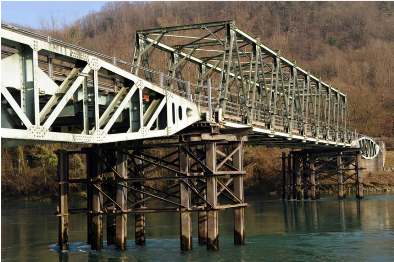
Vue partielle, de côté, travée centrale, face aval (depuis la rive droite)
