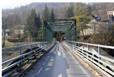
Vue générale, de dessus, chaussée (depuis la rive gauche) Phot. G. Gellert IVR82_20100100451NUCA
