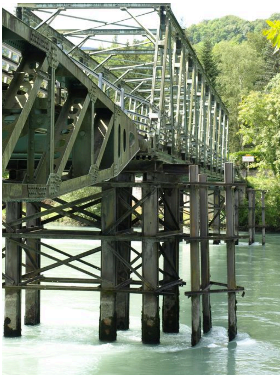
Vue partielle, de côté, face amont (depuis la rive gauche)
