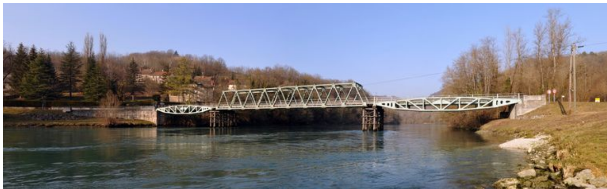
Vue panoramique, face aval (depuis la rive gauche)
