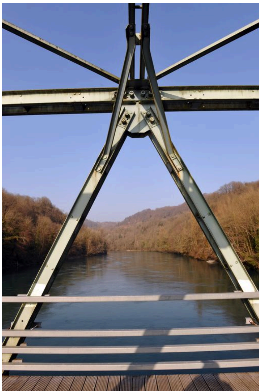
Travée centrale, de dessus, vue de détail : structure métallique, de face
