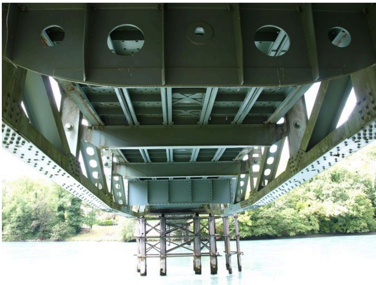
Vue de dessous, travée gauche (depuis la rive gauche)
