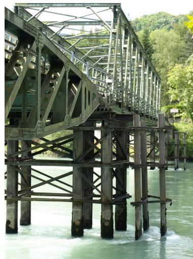
Vue partielle, de côté, face amont (depuis la rive gauche) Phot. B. Decrock IVR82_20100100449NUCA
