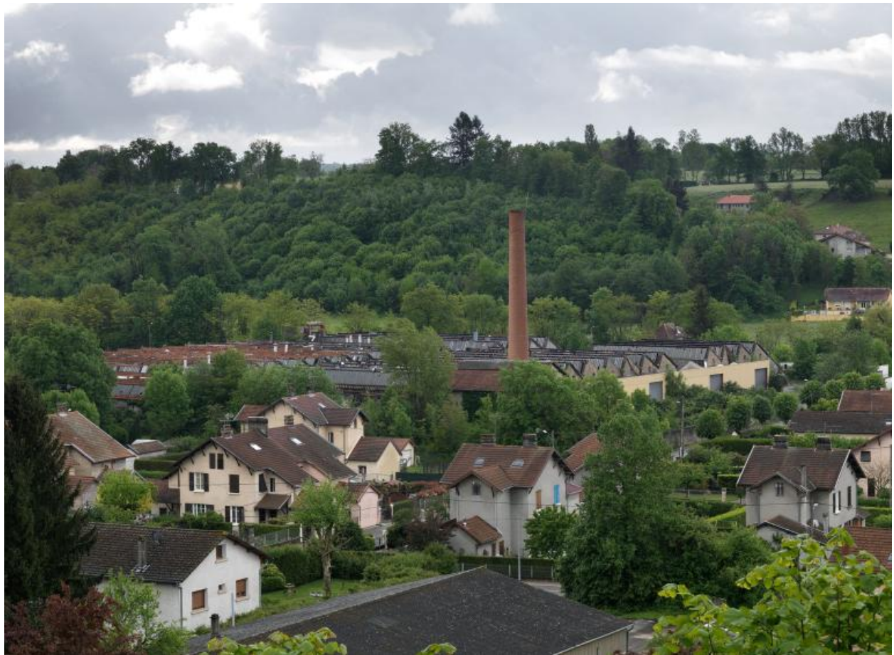
Vue d'ensemble du site de la corderie
