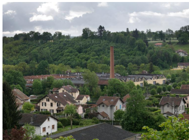
Vue d'ensemble du site de la corderie Phot. Thierry Leroy IVR84_20163800204NUCAQ
