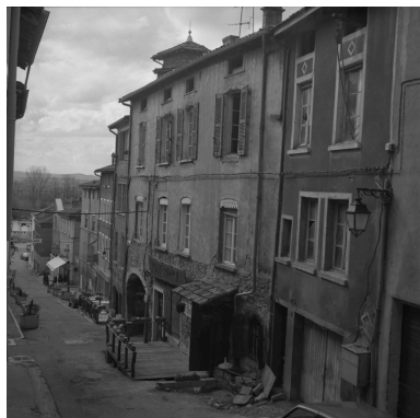
Elévation sur la rue du Port, de l'immeuble au n°4, avec passage couvert dit La Voûte Phot. Jean-Marie Refflé IVR82_19910100403X
