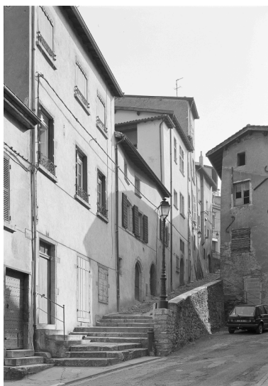
Façade du 6 rue Casse- Cou, et élévation postérieure du 33 Grande rue. Phot. Jean-Marie Refflé, Phot. Eric Dessert IVR82_19910100591P
