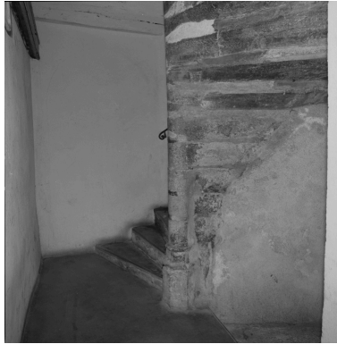
Immeuble, 11 rue du Port, détail de l'escalier en vis, base du noyau à moulures prismatiques. Phot. Jean-Marie Refflé IVR82_19910100381X
