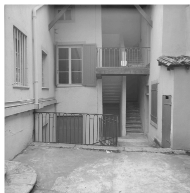
Escalier à cage ouverte sur cour, immeuble 26 Grande rue, parcelle traversante sur rue Montsec. Phot. Eric Dessert, Phot. Jean-Marie Refflé IVR82_19910100592X
