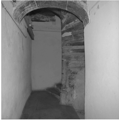
Immeuble, 11 rue du Port, départ de l'escalier en vis. Phot. Jean-Marie Refflé IVR82_19910100380X
