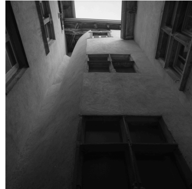
Cour intérieure de l'immeuble, 11 rue du Port, avec cage d'escalier demi-hors-oeuvre. Phot. Jean-Marie Refflé IVR82_19910100382X
