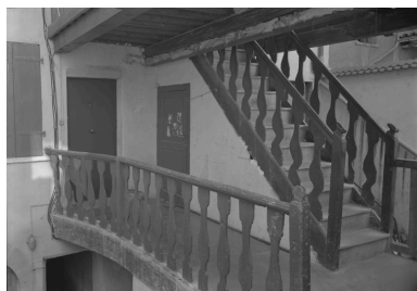
40 Grande rue : cage d'escalier dans la cour. Phot. Jean-Marie Refflé IVR82_19900100279P
