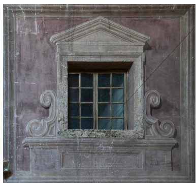
Choeur : fenêtre latérale ornée en trompe l'oeil. Phot. Pascal Lemaître IVR82_20134202536NUCA
