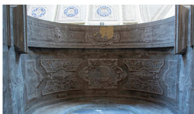
Chapelle de l'Annonciation : intrados de l'arc. Phot. Pascal Lemaître IVR82_20134202533NUCA
