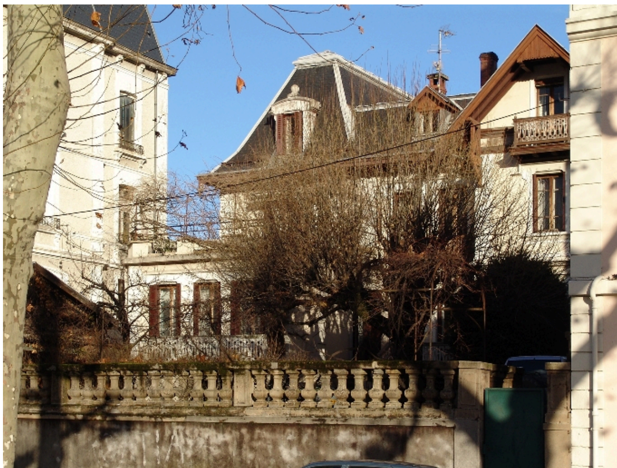
Façade postérieure, vue de trois-quart
