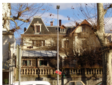
Façade postérieure Phot. François Fouger IVR82_20057300127NUCA
