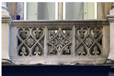
Façade principale, fenêtre du 1er étage, détail du garde-corps Phot. Bernard Ducouret IVR82_20046900116NUCA
