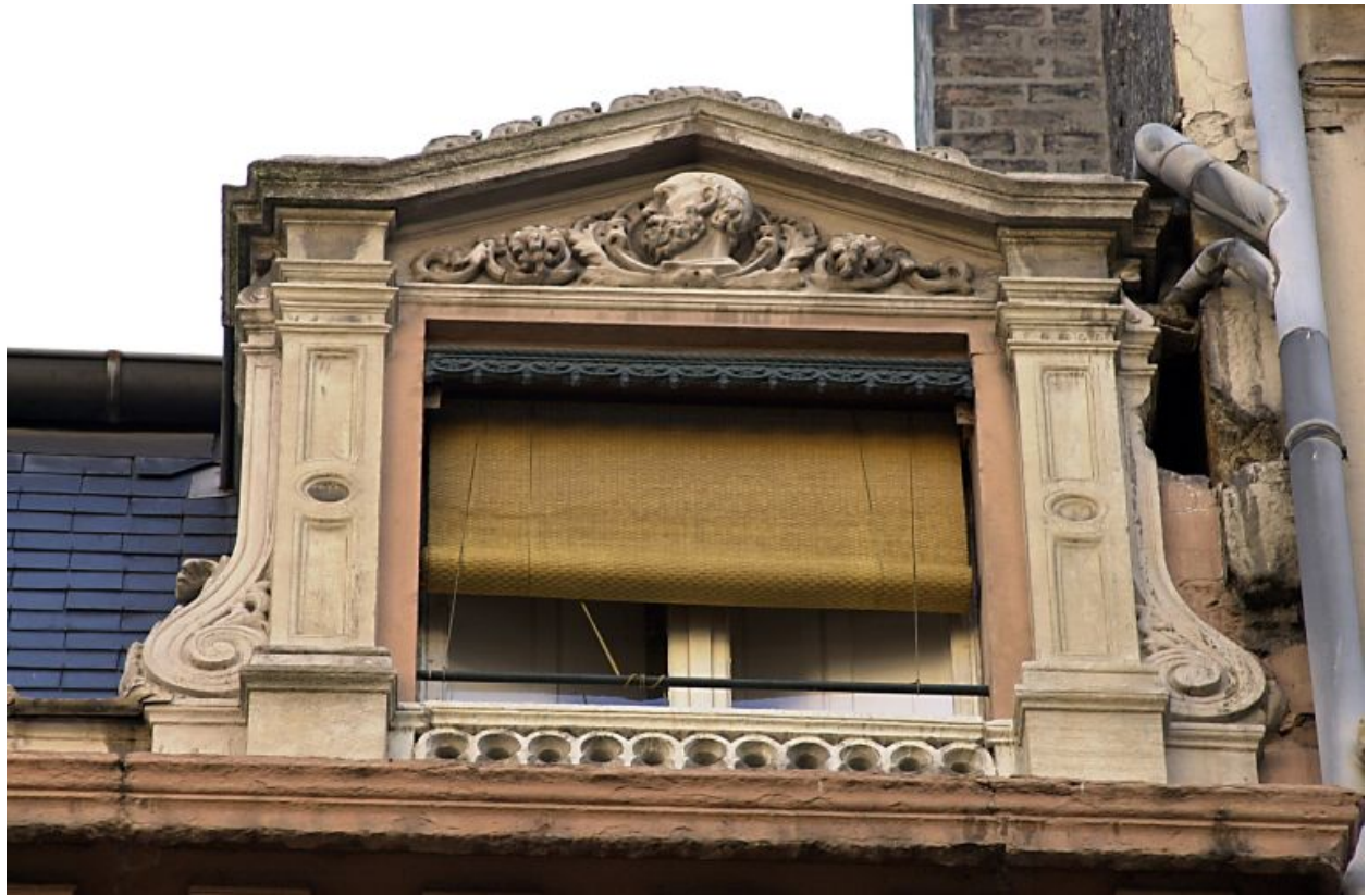
Façade principale, détail de la lucarne latérale droite
