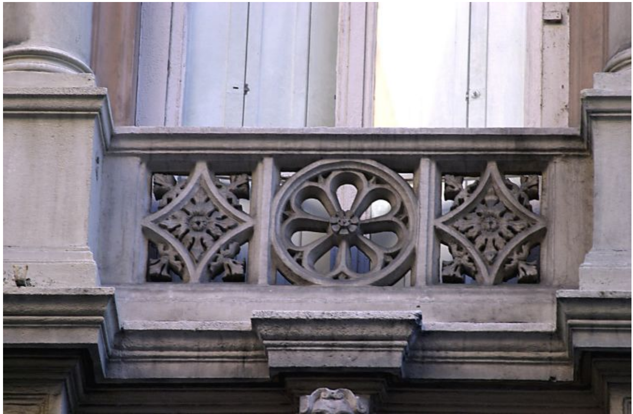
Façade principale, fenêtre du 2e étage, détail du garde-corps
