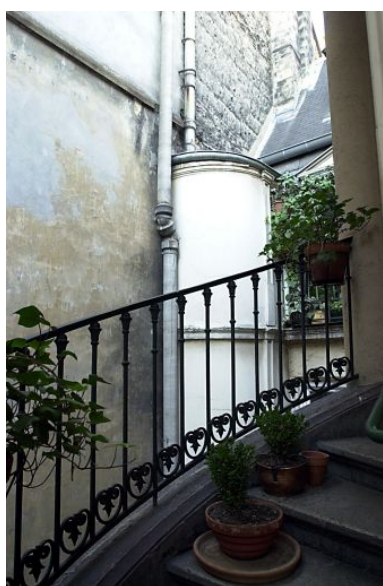
Escalier, dernier étage, détail de la rampe Phot. Bernard Ducouret IVR82_20046900129NUCA
