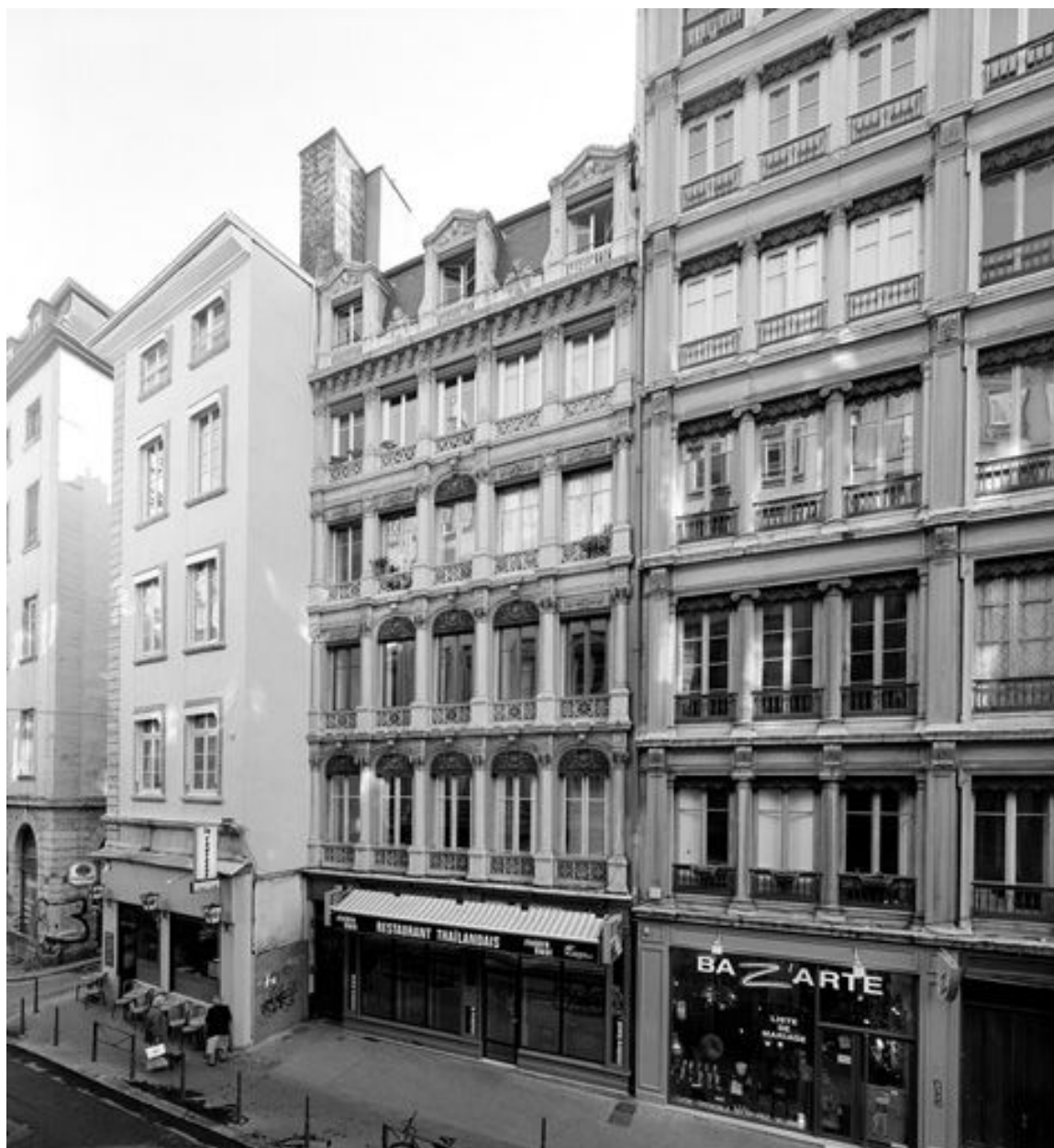
Façade principale, vue générale
