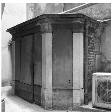
Cour, loge de concierge Phot. Didier Gourbin IVR82_20056902895NUC
