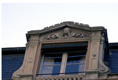
Façade principale, lucarne axiale Phot. Bernard Ducouret IVR82_20046900122NUCA
