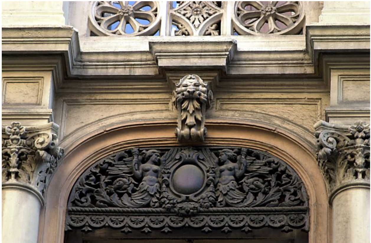
Façade principale, fenêtre du 2e étage, détail du lambrequin
