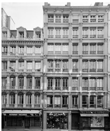
Vue générale de la façade avec celle de l'immeuble mitoyen Phot. Didier Gourbin IVR82_20056902654V
