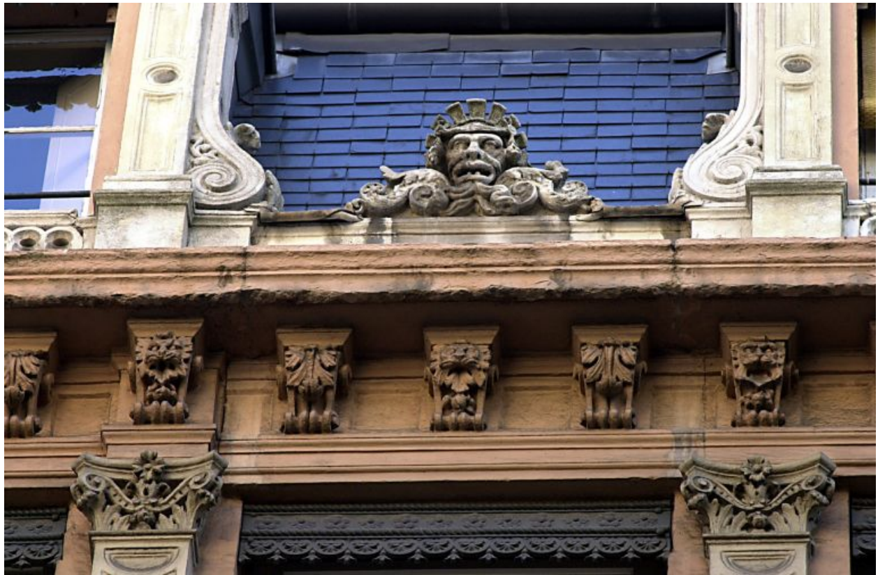
Façade principale, détail de la corniche
