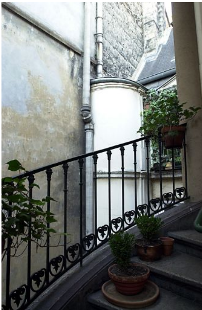
Escalier, dernier étage, détail de la rampe
