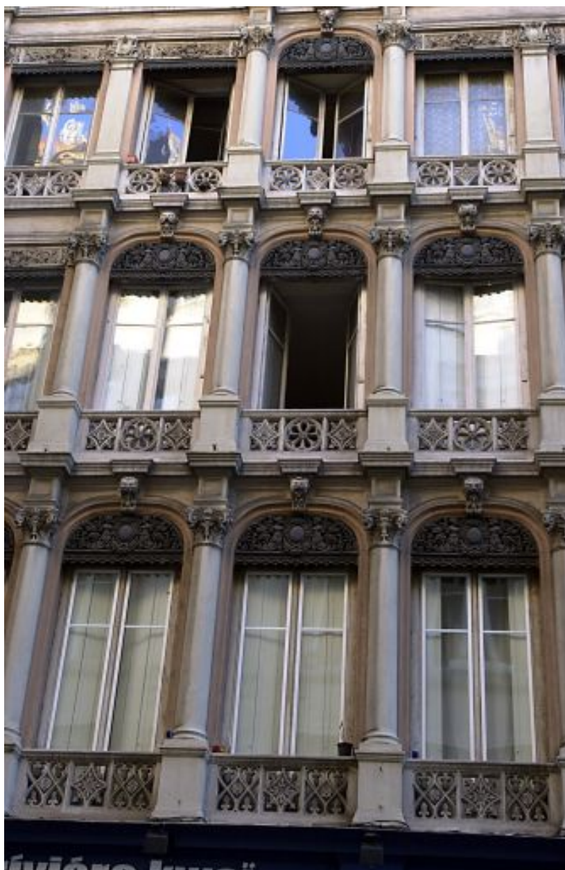
Façade principale, détail de l'élévation
