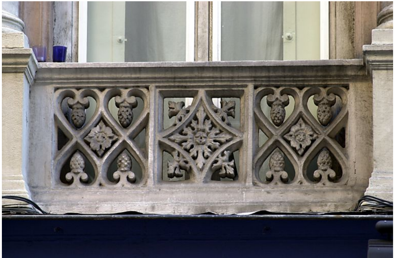
Façade principale, fenêtre du 1er étage, détail du garde-corps
