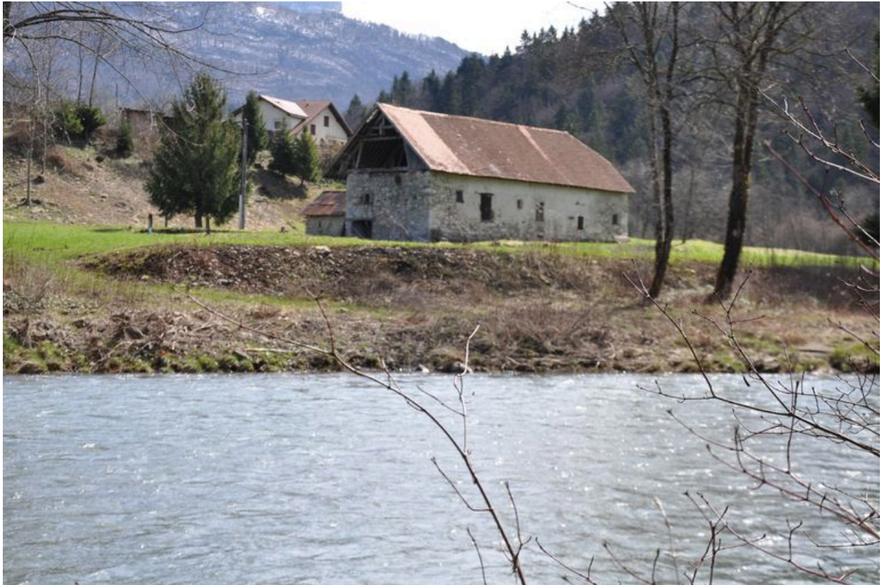
Vue générale du moulin Onnex
