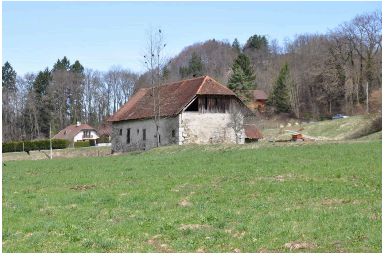
Vue de l'élévation sud-est du moulin
