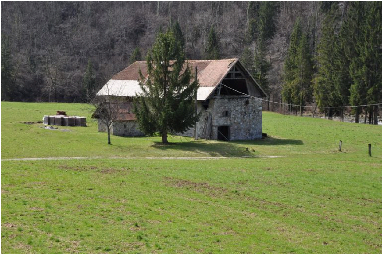
Vue générale du moulin Onnex
