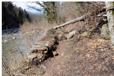
Vue des massifs du canal de dérivation Phot. Samir Mahfoudi, Autr. Samir Mahfoudi IVR82_20107403227NUCA
