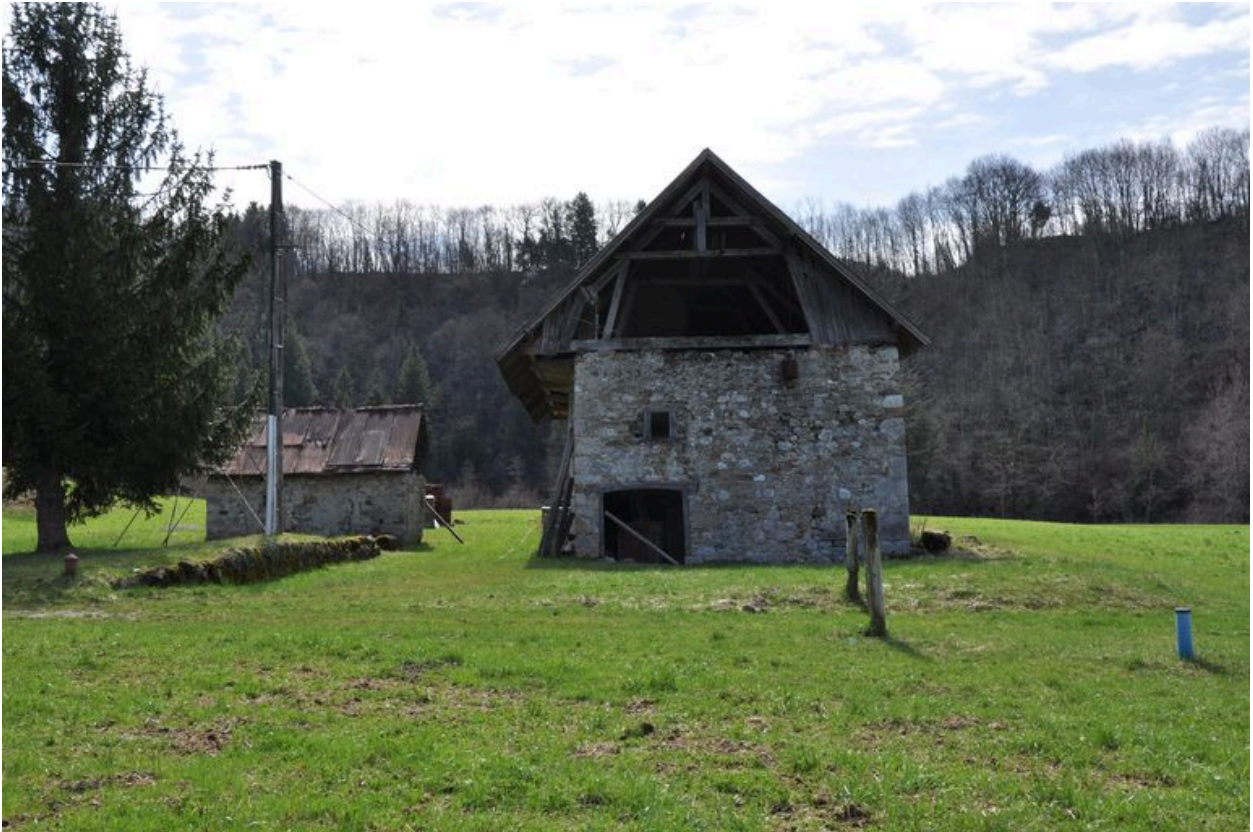
Vue du mur pignon ouest du moulin
