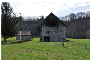
Vue du mur pignon ouest du moulin Phot. Samir Mahfoudi, Autr. Samir Mahfoudi IVR82_20107403231NUCA
