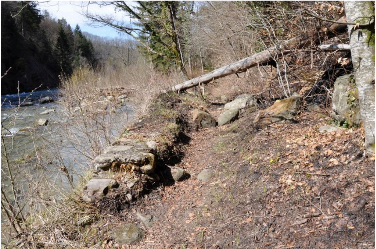
Vue des massifs du canal de dérivation
