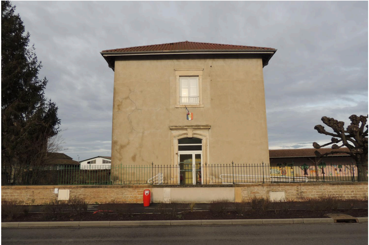
Vue latérale, élévation est.
