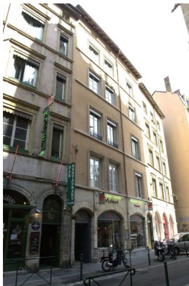
Façade sur rue Phot. Bernard Ducouret IVR82_20046900359NUCA
