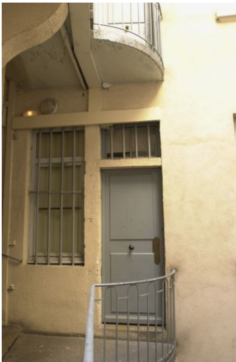
Cour, palier du 2e étage, porte du 1er corps de bâtiment
