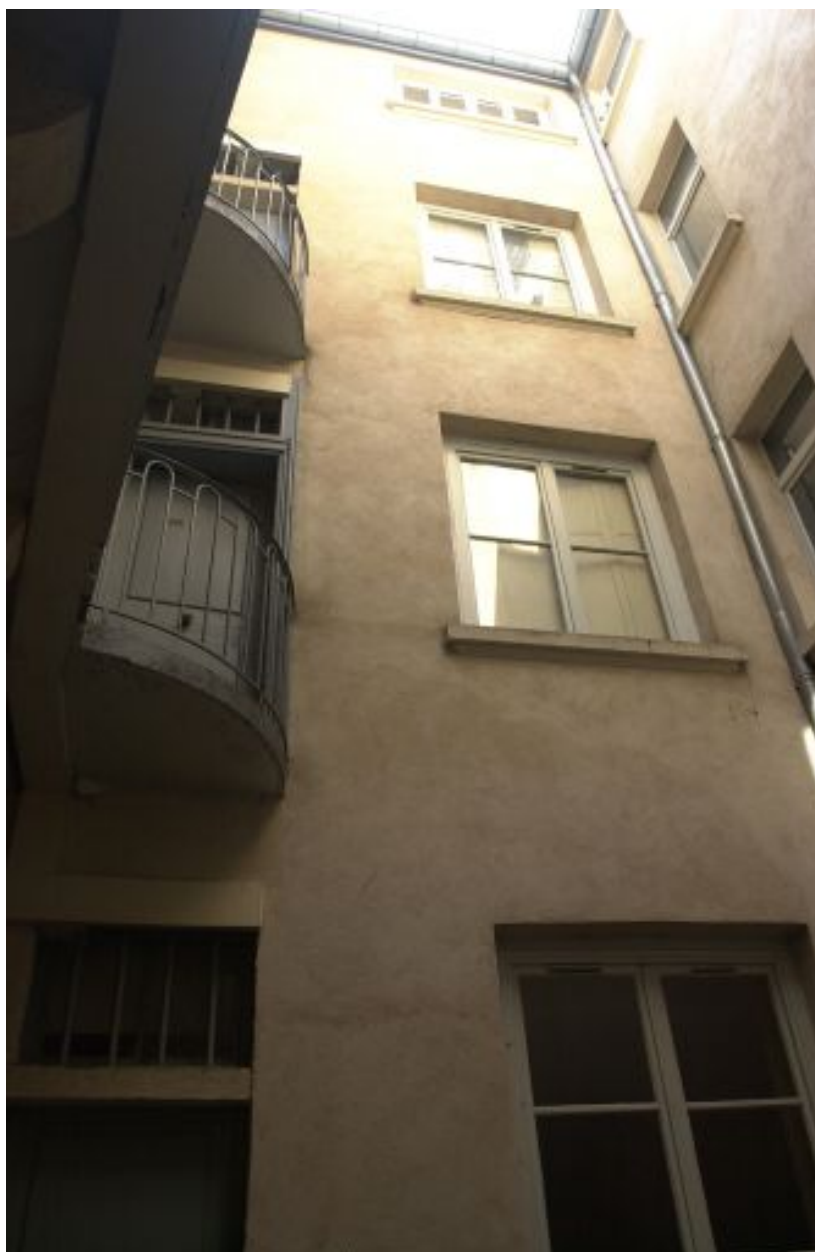
Façade sur cour du 1er corps de bâtiment
