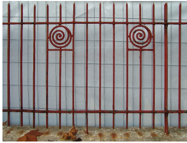
Détail de la grille Phot. François Fouger IVR82_20077300704NUCA
