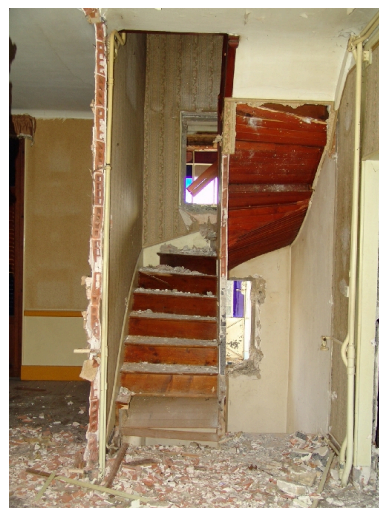
Escalier intérieur Phot. François Fouger IVR82_20077300697NUCA
