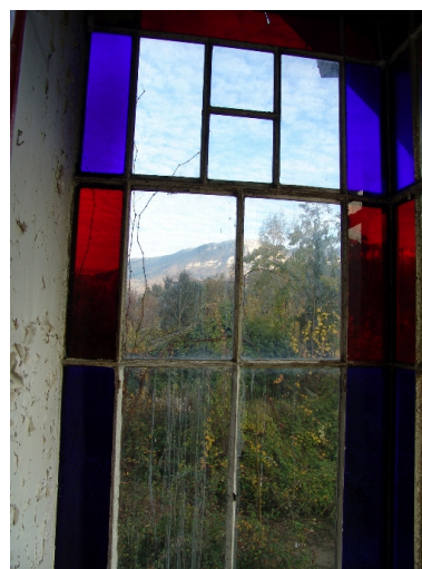
Détail de la verrière Phot. François Fouger IVR82_20077300701NUCA
