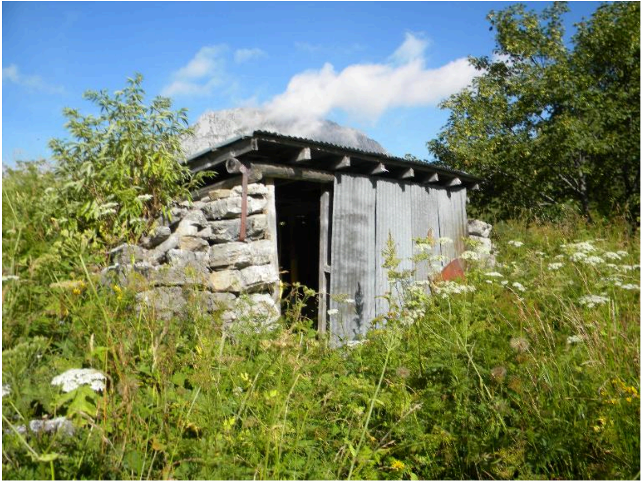
Vue de la remise pour le matériel.
