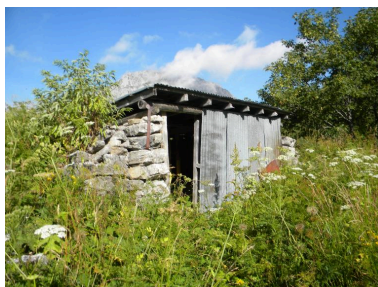
Vue de la remise pour le matériel. Phot. Jérôme Daviet IVR84_20167306803NUCA
