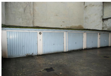
Garages, en fond de cour Phot. Magali Delavenne IVR84_20166901886NUCA
