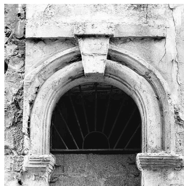
Porte piétonne : arc et tympan de ferronnerie Repro. Jean-Marie Refflé IVR82_19826900009X
