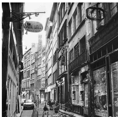
Vue de situation : neuvième immeuble à partir de la droite Phot. Jean-Marie Refflé IVR82_19826900005X
