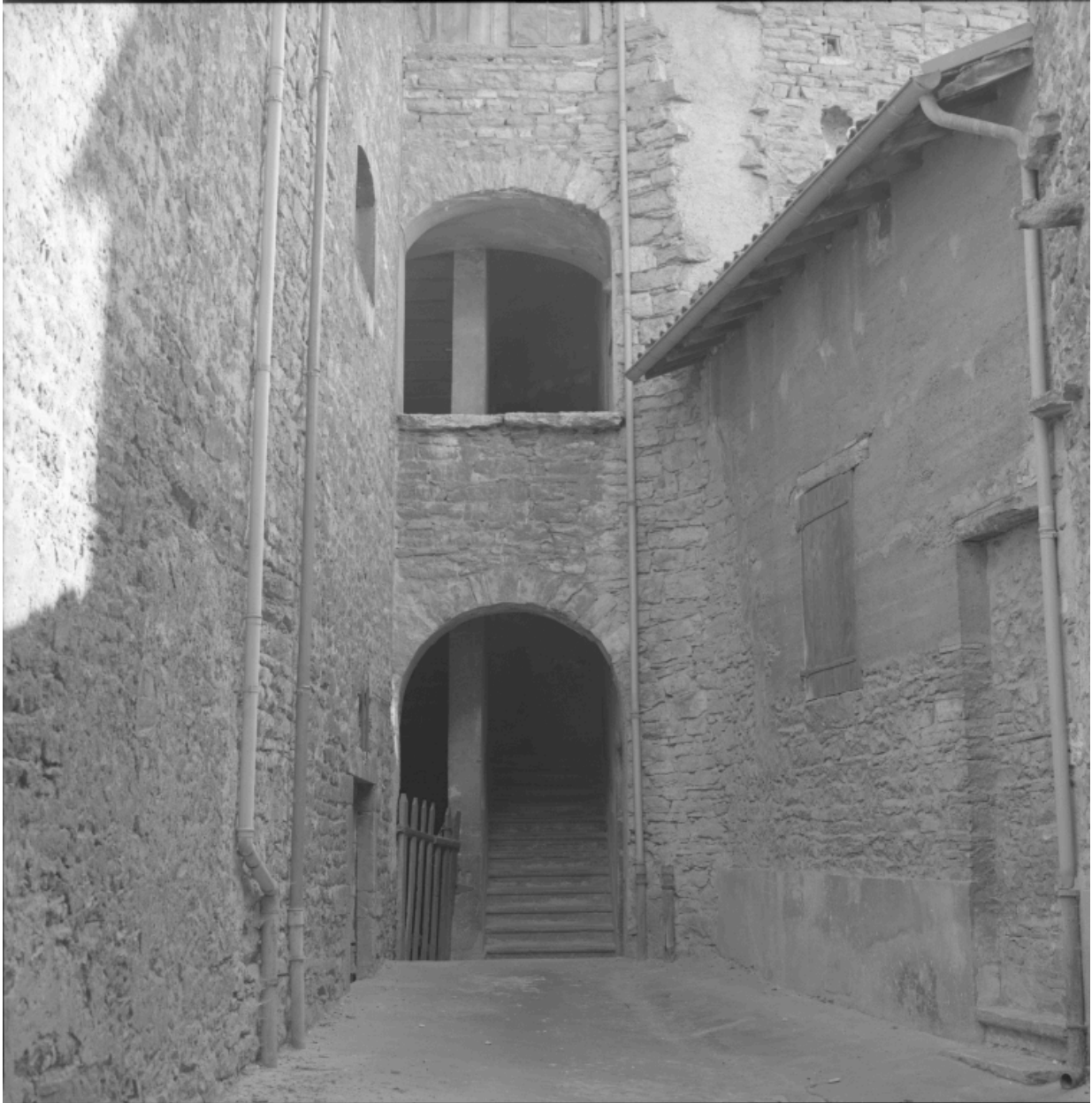
Cage d'escalier du n°5.
