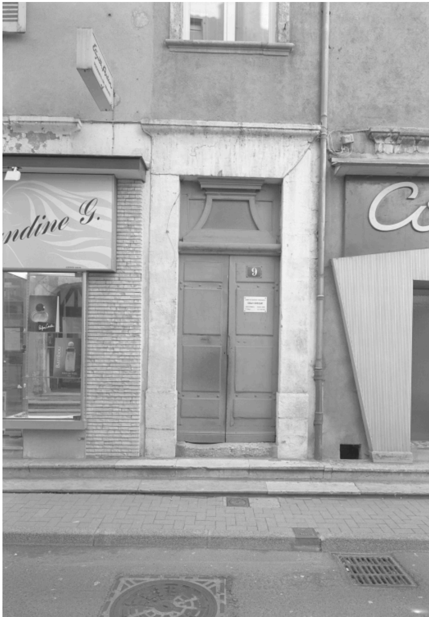
Porte d'entrée sur la Grande rue.
