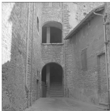
Cage d'escalier du n°5. Phot. Jean-Marie Refflé IVR82_19900100245X
