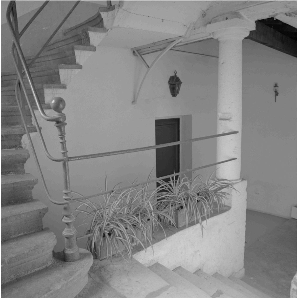
Escalier du n°9, détail.
