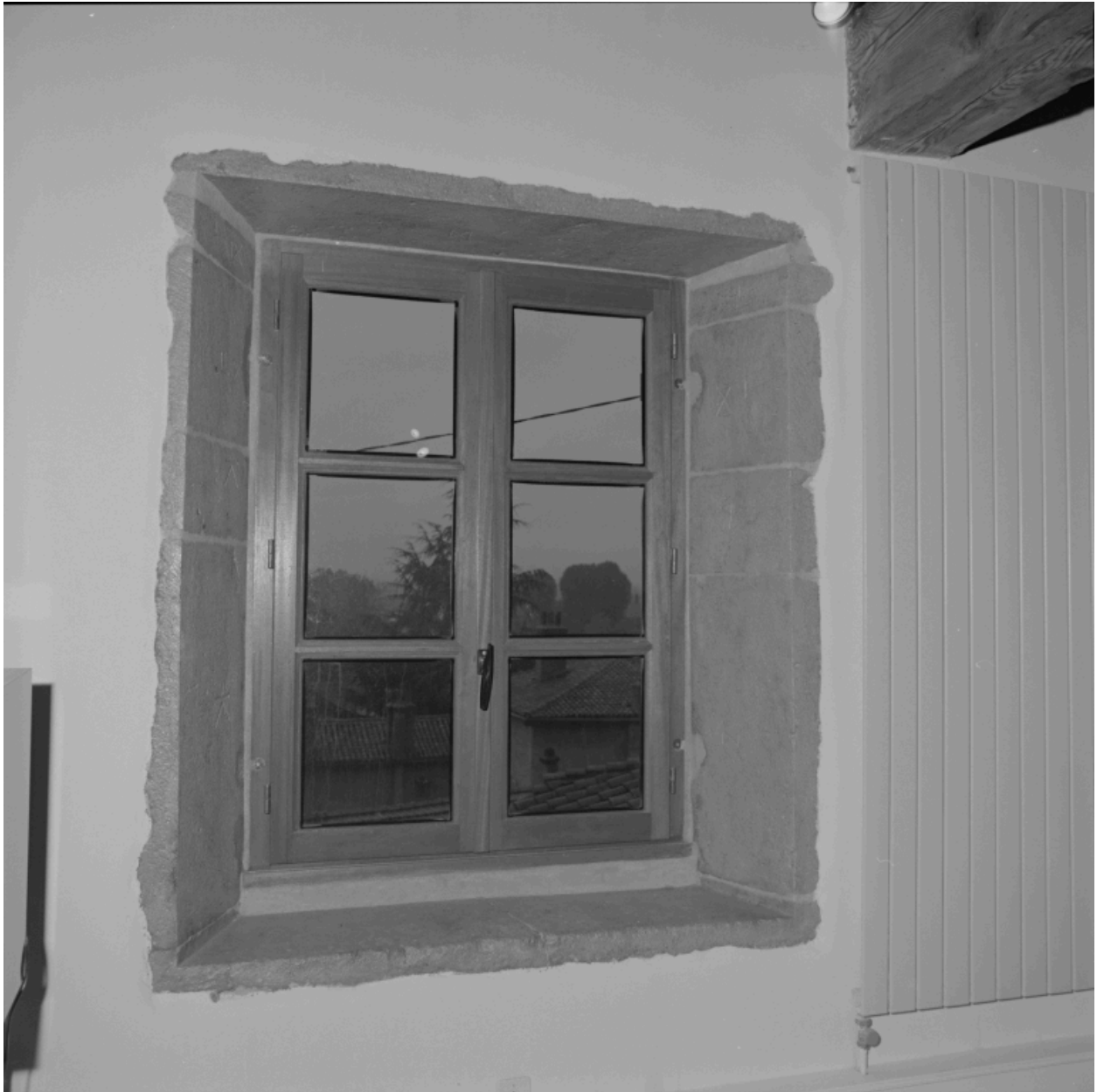
Fenêtre avec marques de tâcheron.
