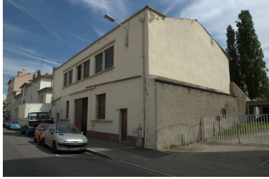
Vue générale ouest Phot. Nadine Halitim-Dubois IVR82_20086900483NUCA
