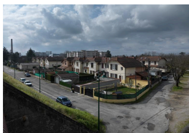
Vue d'ensemble de la cité SLSA Phot. Thierry Leroy IVR84_20160100103NUCAQ
