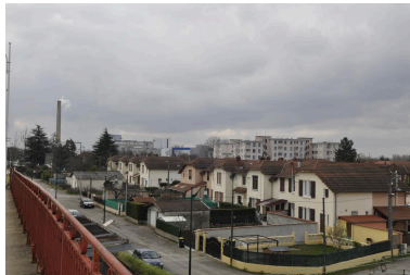
Vue d'ensemble des maisons ouvrières Phot. Nadine Halitim-Dubois IVR84_20160100126NUCA
