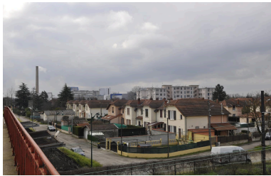
Vue d'ensemble de la cité ouvrière Phot. Nadine Halitim-Dubois IVR84_20160100125NUCA
