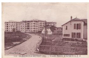
Carte postale, vue des grandes maisons de la cité S.L.S.A. (archive privée) Phot. Nadine Halitim-Dubois IVR84_20160100119NUC
