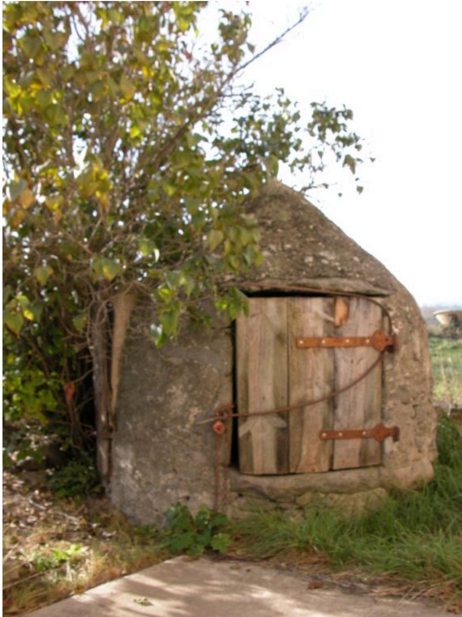
Vue d'ensemble du puits obus.
