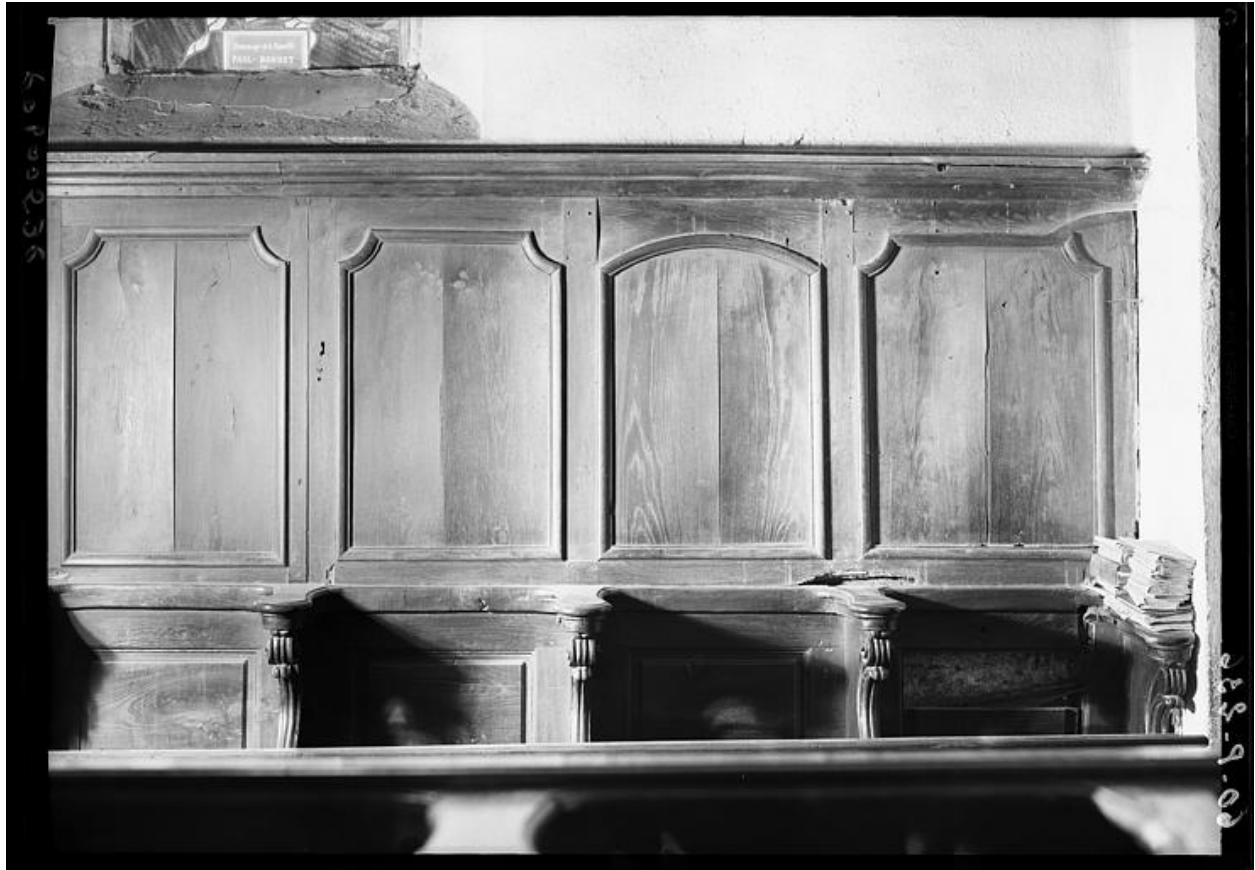
Vue d'ensemble du second groupe de stalles aujourd'hui disparu. Négatif original, 1976. Médiathèque de l'architecture et du patrimoine (archives photographiques). SAP01-60P00236
