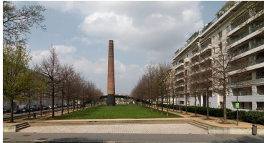
Vue d'ensemble du parc et de la cheminée Phot. Martial Couderette IVR82_20096900285NUCA
