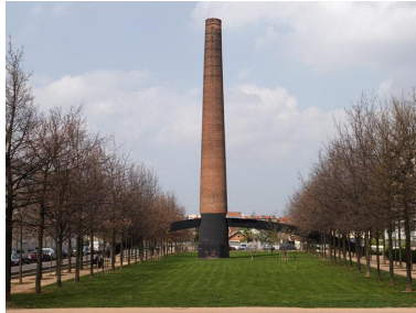
Cheminée avec passerelle réalisée par l'artiste Felice Varini Phot. Martial Couderette IVR82_20096900286NUCA
