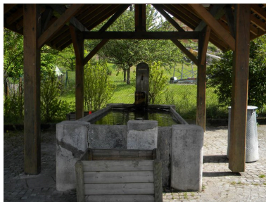
Vue de face du bassin avec la charpente du toit le couvrant. Phot. Jérôme Daviet IVR82_20117403681NUCA
