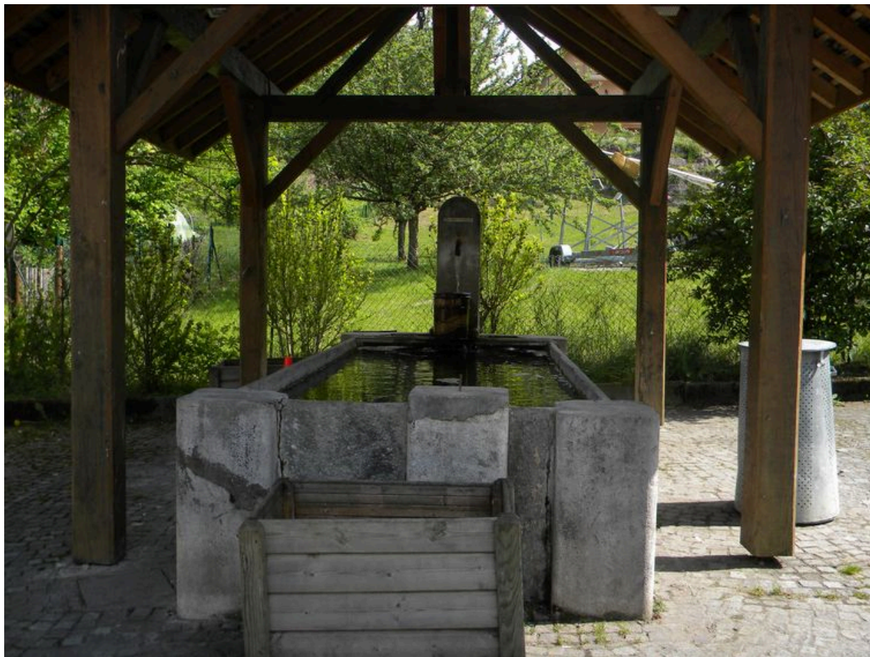
Vue de face du bassin avec la charpente du toit le couvrant.
