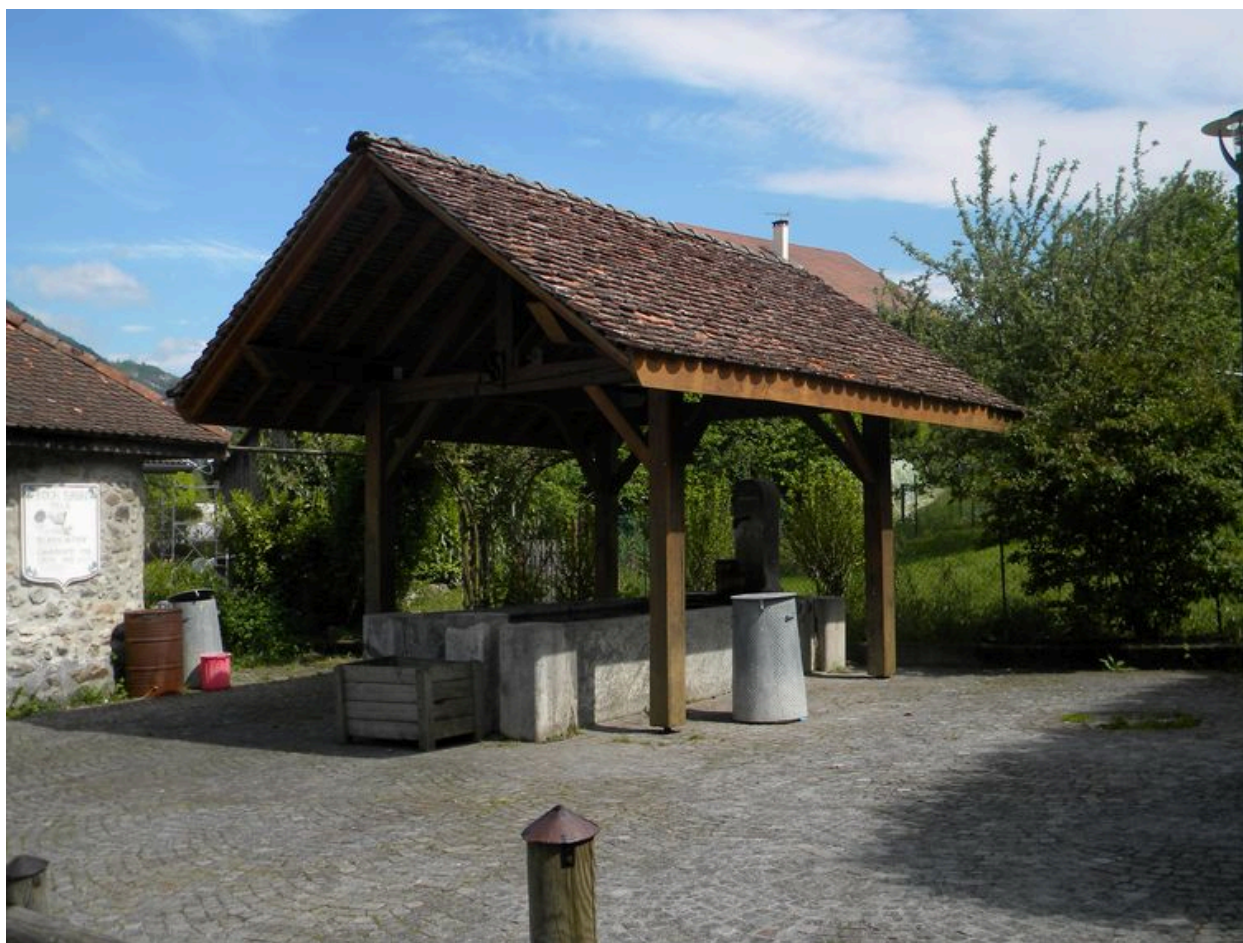
Vue générale du bassin couvert.
