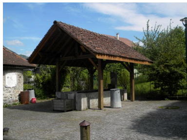
Vue générale du bassin couvert. Phot. Jérôme Daviet IVR82_20117403680NUCA
